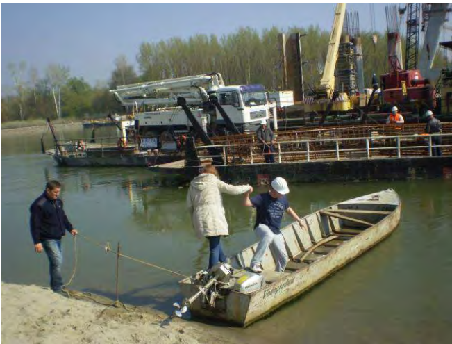
Pristup vodenom radilištu pomoću čamca, a betonaža ide crpkama;
