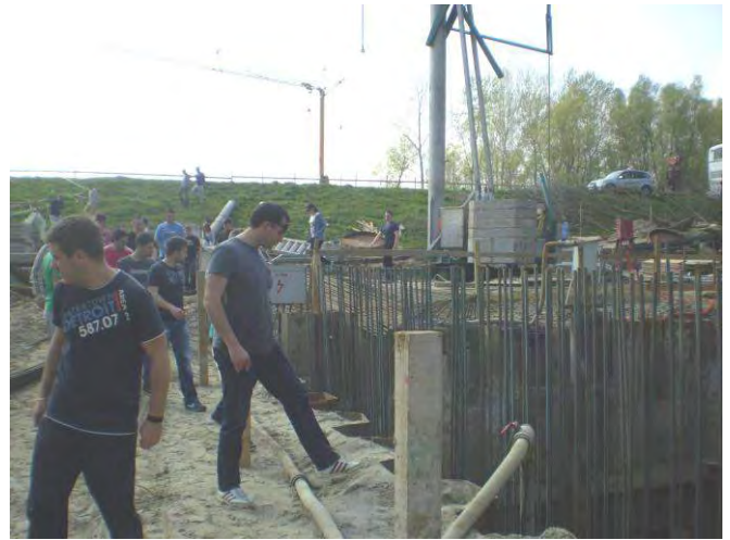
Građevinska jama crpne stanice u inundaciji Dunava (dunavske račve),
