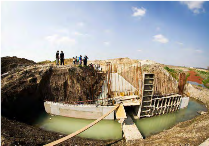
Najuzvodnija i najveća ustava za navodnjavanje na kanalu;
