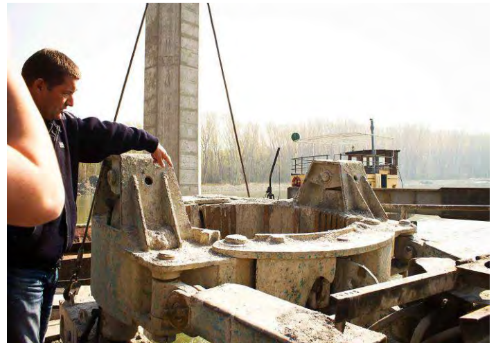
Voditelj gradilišta objašnjava tehnologiju radova u vodi;
