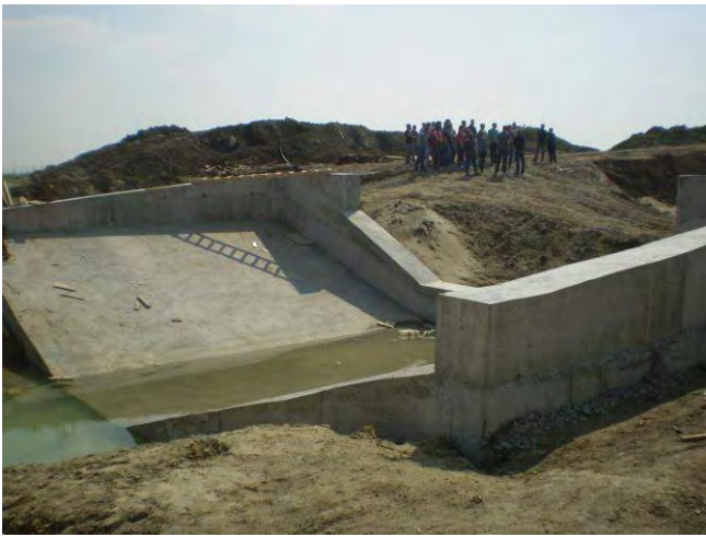
Vodna stepenica od betona na prijelazu strmijeg u blagi dio kanala;
