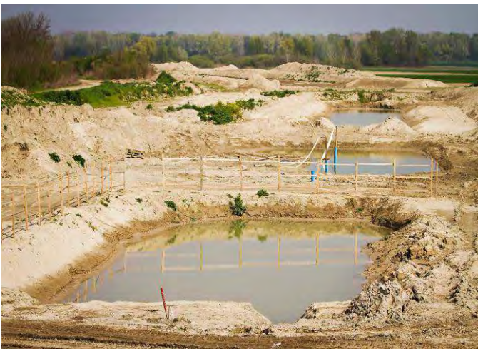
Probni iskopi i formiranje profila revizibilnog zemljanog kanala;
