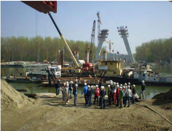
Potiskivanje metalne konstrukcije mosta zahtjeva pomoćno stupište;
