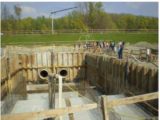
Jama s druge, branjene strane na kojoj će se izvesti strojarnica;
