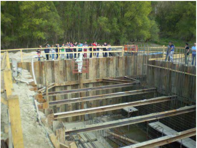
Od procjednih voda zaštita je ostvarena crpljenjem iz bočnih zdenaca;
