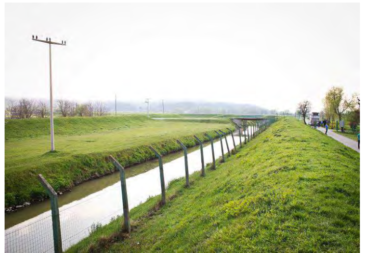
Odvodni dio kanalske mreže primjereno održavan kao i krug crpne stanice;
