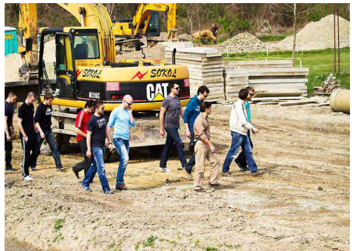
Obilazak zemljanih radova uz diskusiju o stabilnosti obala kanala;
