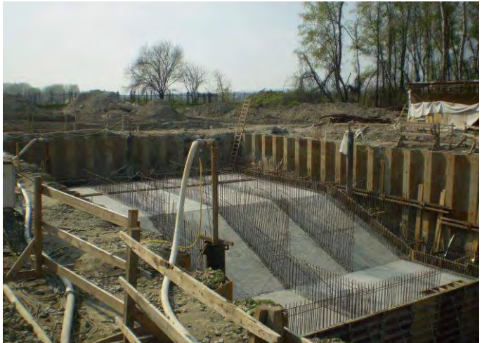
Oslonac za tuneliranje postaje ulazno/izlazna građevina crpne stanice;
