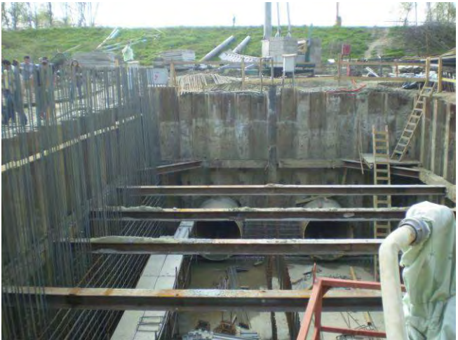
Provodne cijevi probušene su kroz tijelo nasipa i obložene (kao tuneli);
