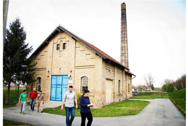
Zadržan je dimnjak parne kotlovnice iako joj je prostor prenamijenjen;
