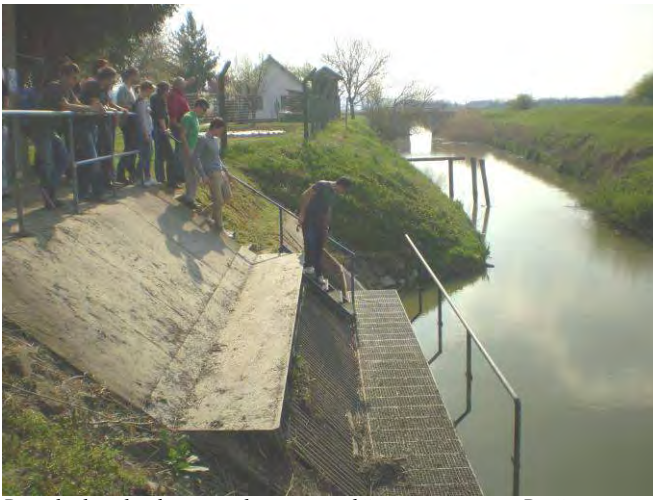
Dovodni kanal i ulazna građevina stogodišnje crpne stanice Draž;
