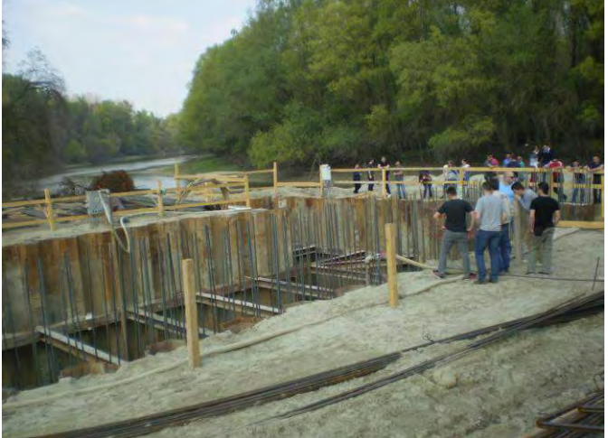
Duboka jama (zahvata/ispusta) osigurana je čeličnim talpama i razupiranjem;
