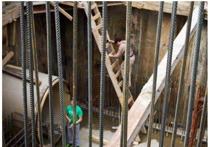
Jedinstvena prilika da se prođe podzemnim cjevovodom je iskorištena;
