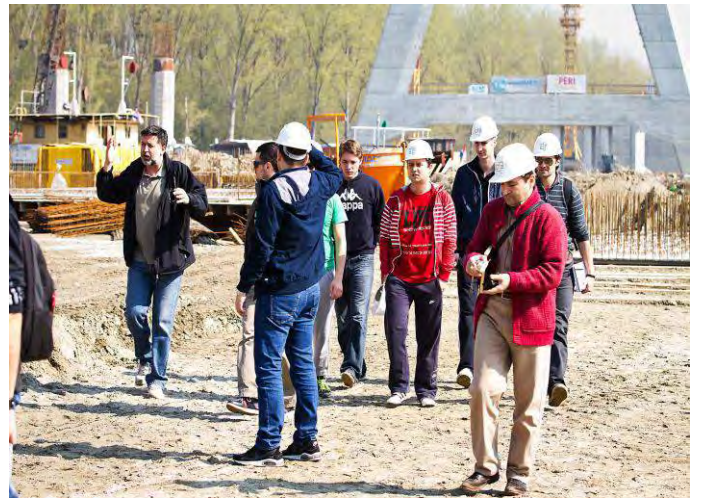
Nadzorni inženjer (Pfajfer D.) pratio je temeljenje;
