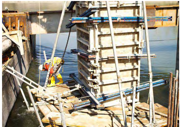
Betonaža stupova u Dravi sa plovila specijalno spojenih za radove;
