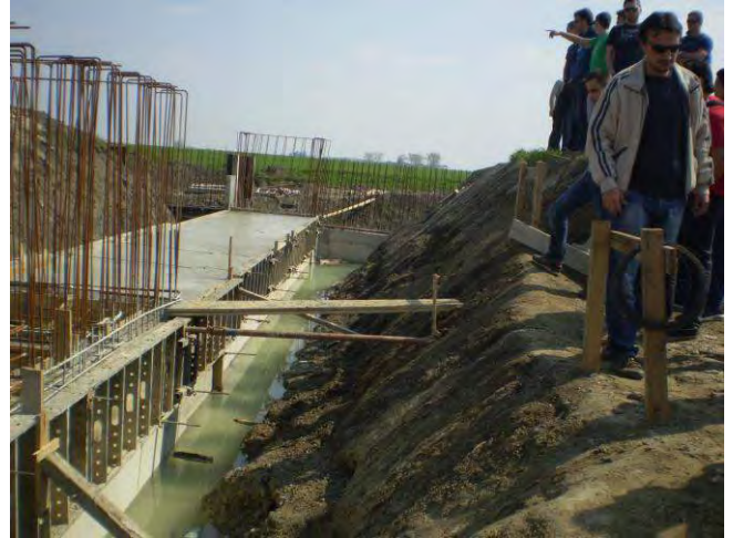
Armiranje i betoniranje pravokutne cijevi ustave s otvorima za zatvarače;
