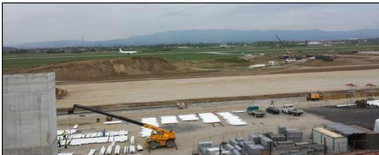
Kolničke konstrukcije prometno–manevarskih površina za kretanje zrakoplova projektirane su kao asfaltne ili betonske, ovisno o namjeni. Asfaltna kolnička konstrukcija staza za vožnju debljine je 70 cm, sastoji se od 30 cm drobljenog kamena, sloja kamena stabiliziranog cementom debljine 20 cm te tri sloja asfalta ukupne debljine 20 cm (AC 16 surf PmB, AC 22 bin PmB, AC 32 base 50/70).
