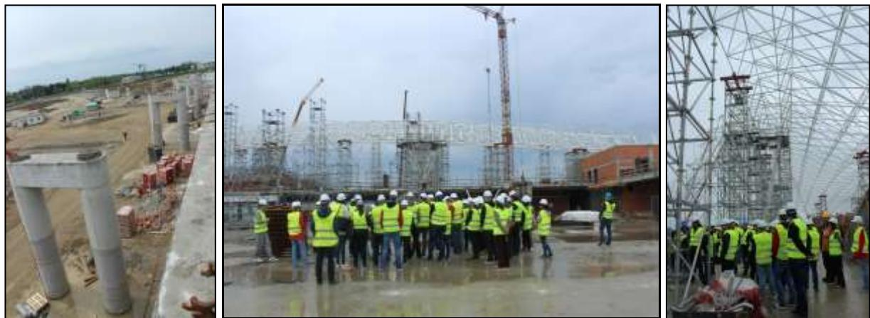
Studenti su imali priliku vidjeti radove na izvođenju zgrade novog putničkog terminala projektiranog s dvije nosive strukture: armiranobetonske konstrukcije zgrade i čelične konstrukcije krova. Krovna konstrukcija je dizajnirana u obliku prostorne čelične rešetke od montažnih čeličnih cijevi; sastoji od gornjih i donjih pojasa povezanih dijagonalama, samo što su osi gornjeg pojasa izmaknute u odnosu na osi donjeg pojasa za 1.8 m pa dijagonale tvore bridove prostornih piramida.
