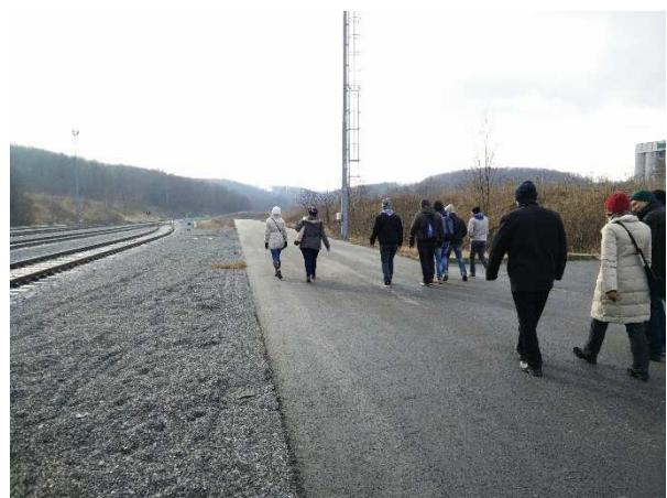
Na prijelimo-otpremnoj skupini studentima je prikazana kolosiječna situacija s 5 kolodvorskih kolosijeka s 8 skretnica, s uređenim manevarskim stazama, objektom za boravak osoblja i pristupnom cestom do samog pogona tvornice koja je izvedena u betonskom kolniku, za utovar i istovar tereta.
