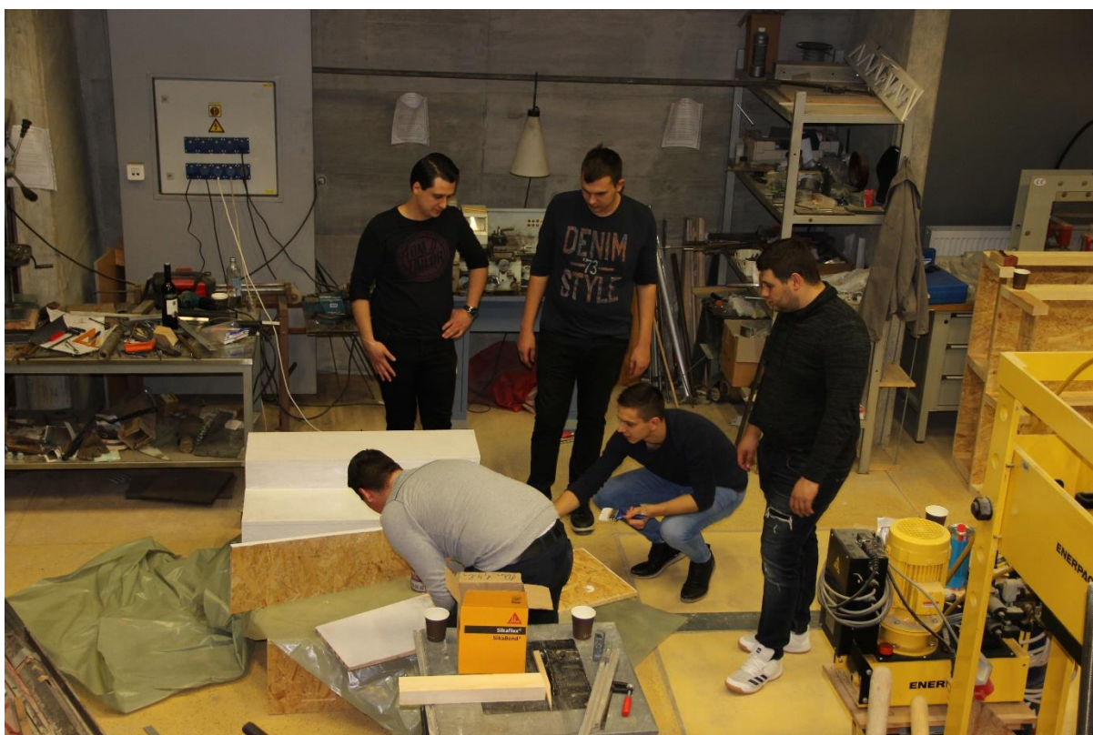
Završne operacije – nanošenje temeljnog premaza na „drvenu“ podlogu
