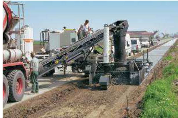
Betonski finiše u radu
