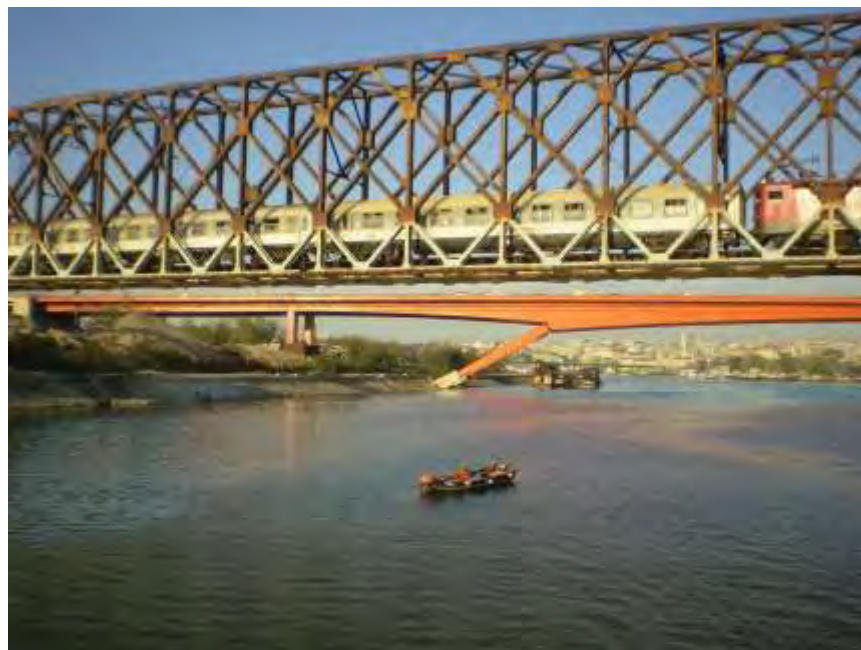
Obnovljena konstrukcija Gazele i rešetkasti željeznički most
