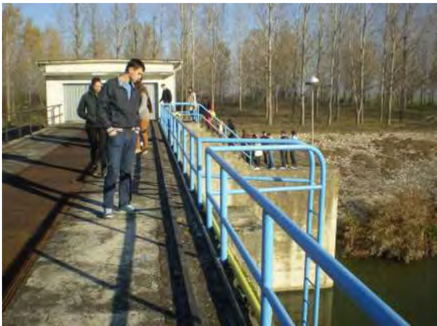
Zaštitna (protupoplavna) ustava u Odžacima
