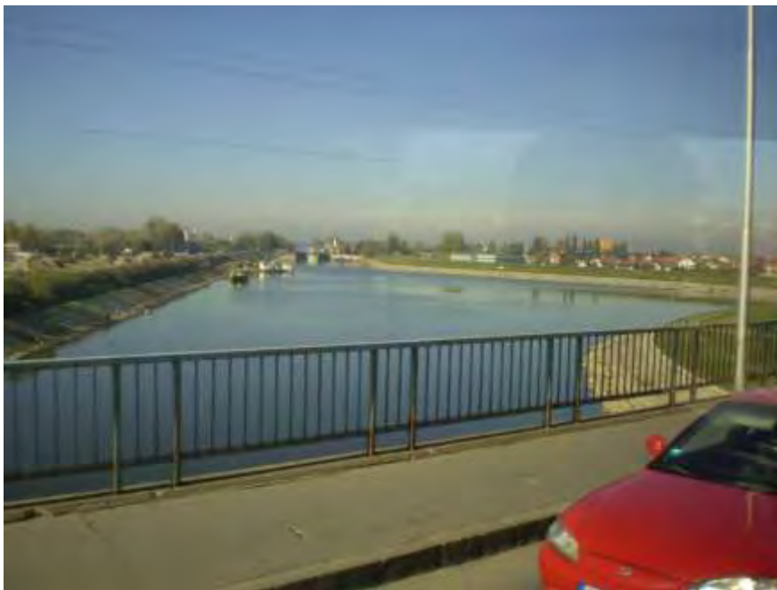
Okretište za brodove na kanalu i hidro-čvor Novi Sad
