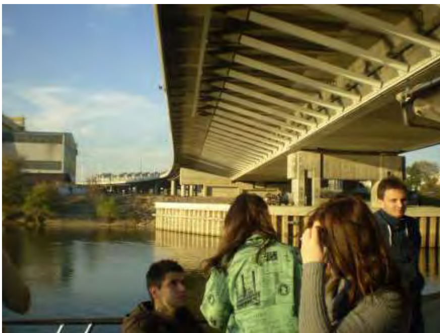
Stupište, upornjak i nosiva konstrukcija Mosta na adi
