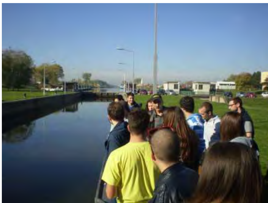
Komora brodske prevodnice u pražnjenju
