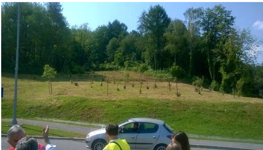
Slika 6. Izgled klizišta u Orahovici nakon sanacije
