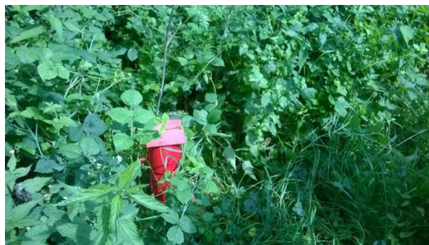
Slika 9. Završetak inklinometarske instalacije na klizištu Duzluk.
