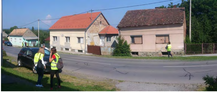
Slika 2. Klizište u Našicama – uočavanje elemenata klizišta i posljedica klizanja na objekte.
