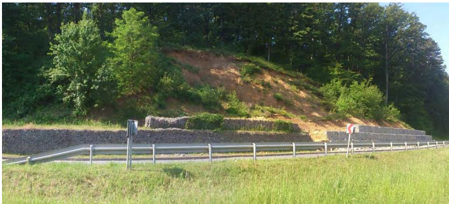
Slika 4. Sanacija odrona/klizanja na cesti Našice-Orahovica kod mjesta Donja Motičina izvedena potpornim zidovima od gabiona.
