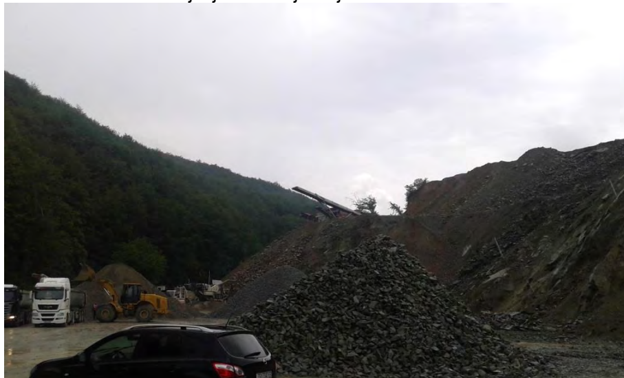
Slika 12. Iskop osnovne stijene u kamenolomu Radlovac
