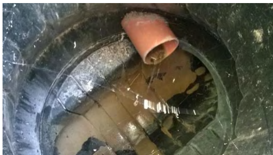
Slika 7. Provjera funkcioniranja sustava drenaže: tečenje vode iz drenova u sabirni šaht.
