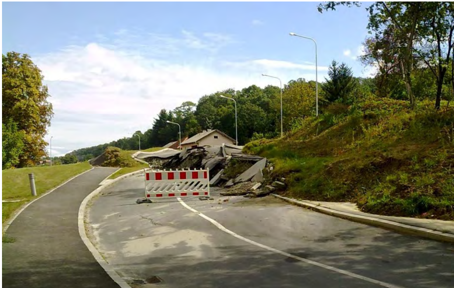
Slika 5. Izgled klizišta u Orahovici prije sanacije
