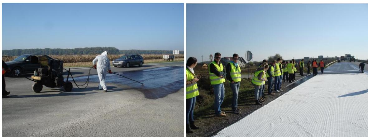
Priprema kolnika sastojala se od frezanja postojećeg asfalta te ravnomjernog špricanja bitumenske emulzije s polimer bitumenom u svrhu osiguranja boljeg prianjanja mreže.
