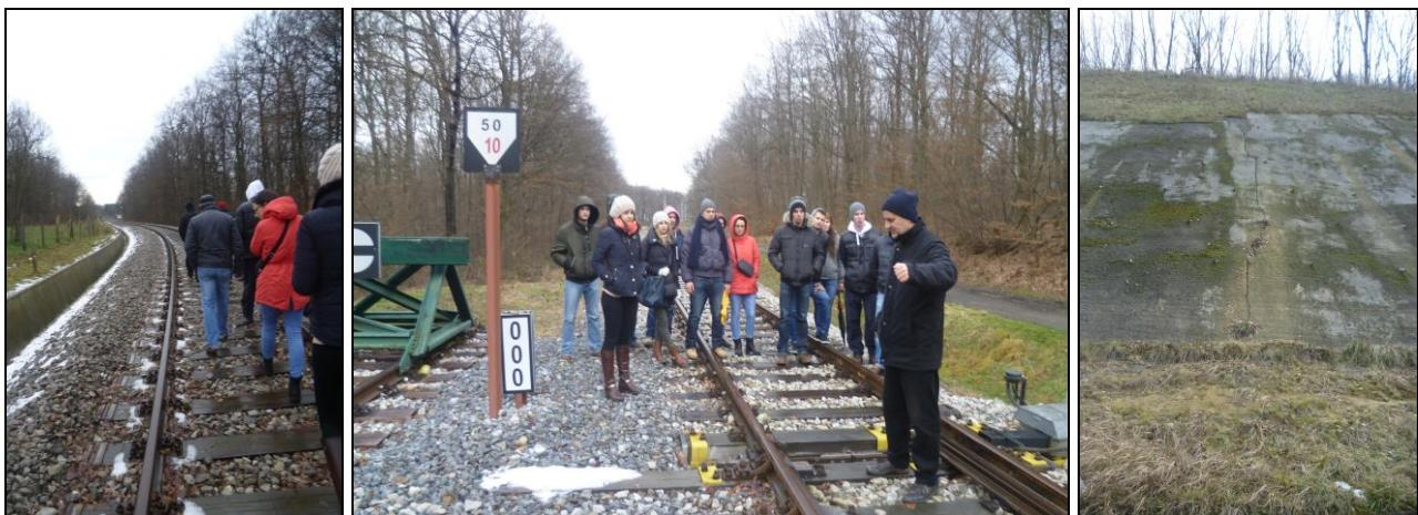
Studenti su upoznati s tijekom izgradnje ovog kolosijeka, na kojemu su za razliku od klasičnog remonta gdje se uglavnom radi na zamjeni elemenata gornjeg ustroja, radovi na izgradnji kolosijeka uključivali sjeću šume, čupanje panjeva, skidanje humusa, izgradnju novog trupa pruge (nasipi, usjeci, zasjeci) s pripadajućim objektima (mostovi, propusti, odvodni jarnici, drenaže) te izgradnju gornjeg ustroja (kolosijeci sa skretnicama).
