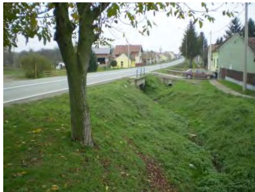
Pogled potokom uzvodno prema pregradi (nekad plavljena zona)
