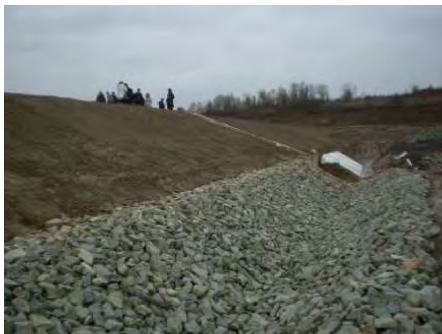
Uz nizvodni pokos drenažni sustav završava odvodnim kanalima
