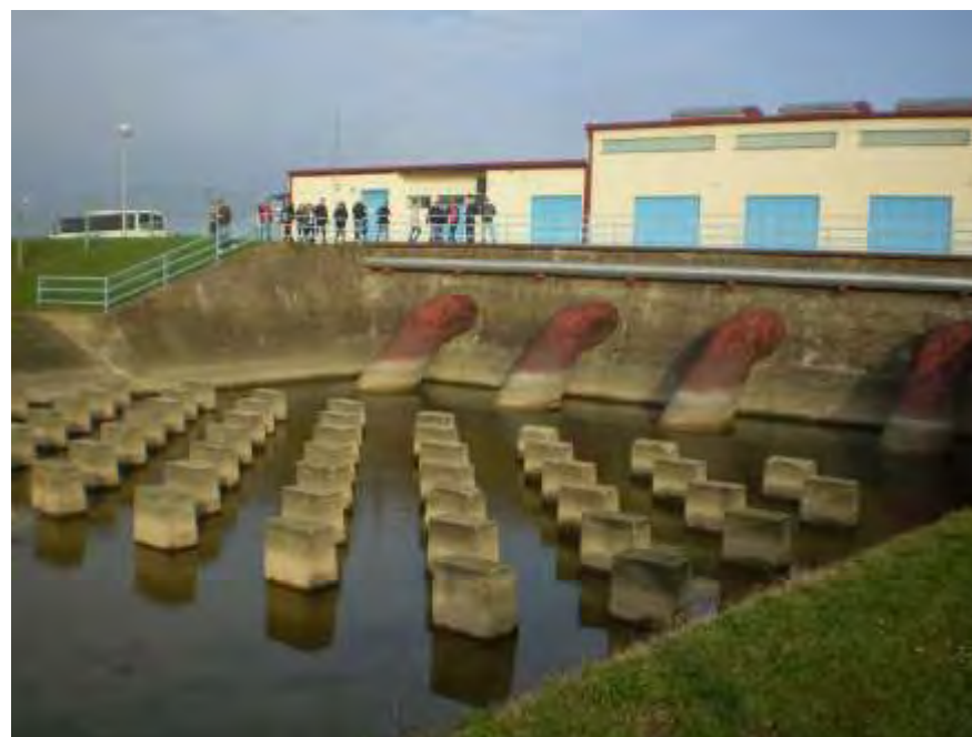
Ispusna građevina i disipatori energije toka vode
