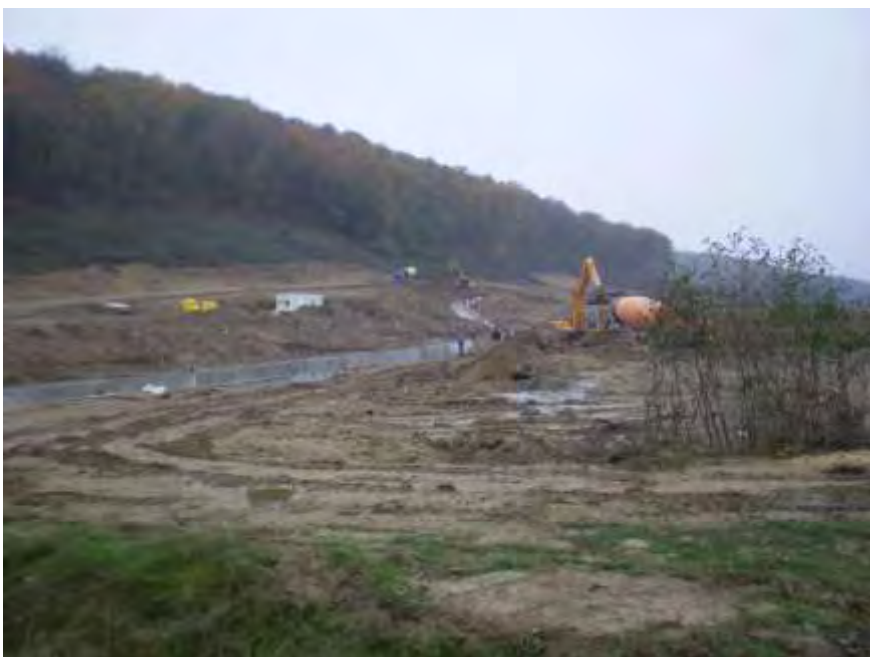
Radovi na brzotoku preljeva
