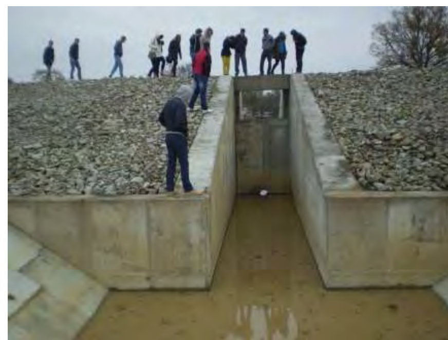
Propusna građevina ima ispust i preljev (zaštita 50-god. PP)
