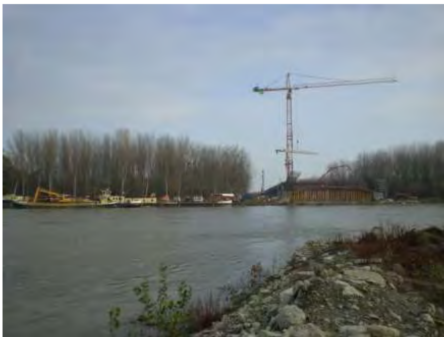
Npreduje i pilon na baranjskoj strani nakon pojačane zaštite obale
