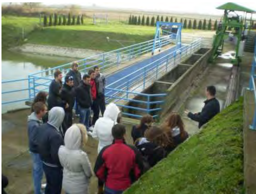
Ulazna građevina (zapornica, rešetka, čistilica) crpne stanice Dvor
