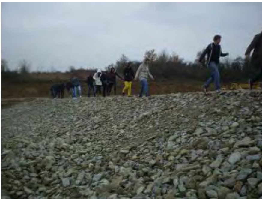
Uzvodna obloga pokosa retencijske pregrade Piljevačka glava
