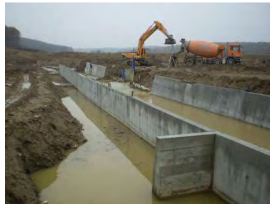
Temeljenje evakuacijskih objekata i betonaža uz probleme s vodom
