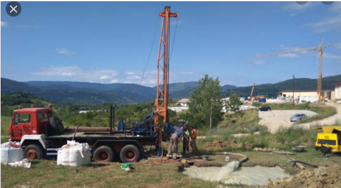
Bušenje sa bentonitnom isplakom
