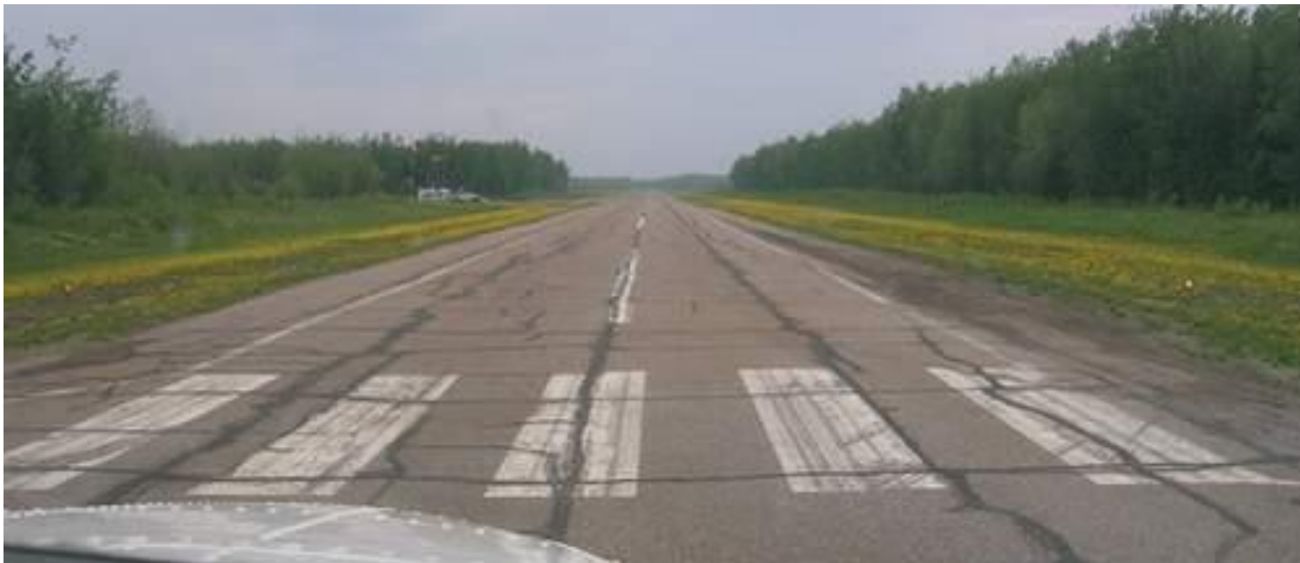
Pukotine na uzletno-sletnoj stazi
