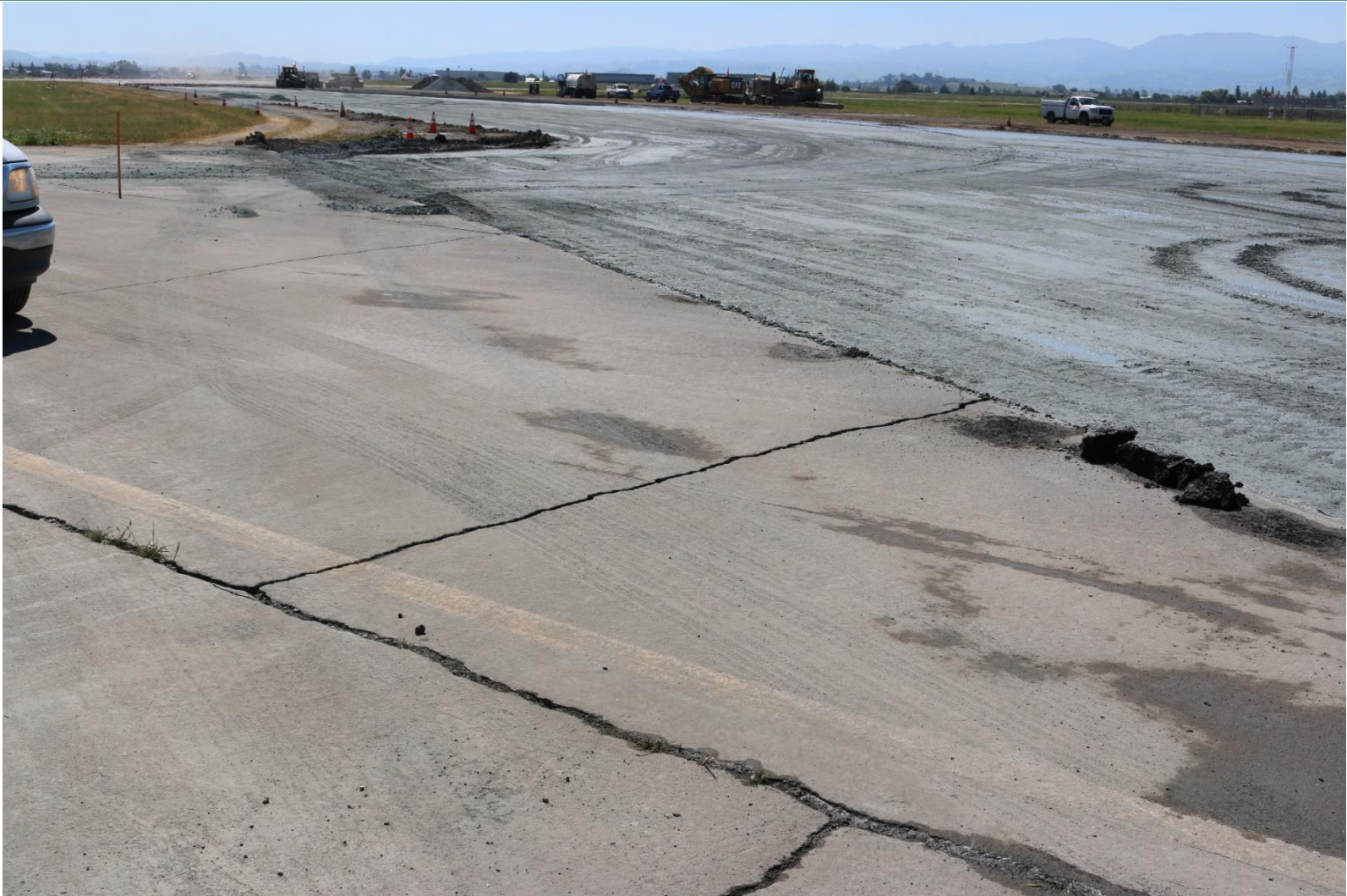
Pukotine na kolniku operativnih površina aerodroma
