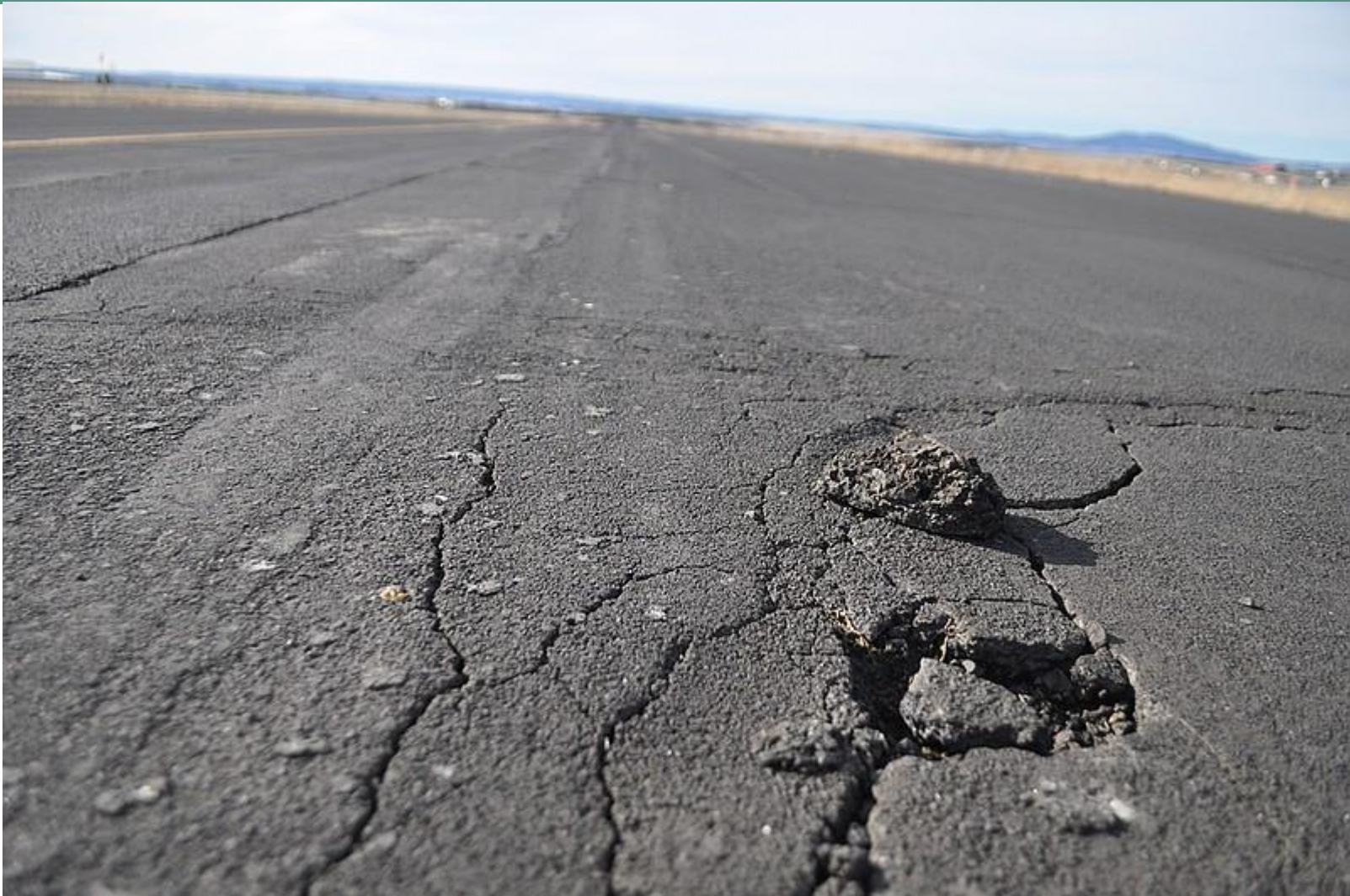
Pukotine i rupe na kolniku uzletno-sletne staze
