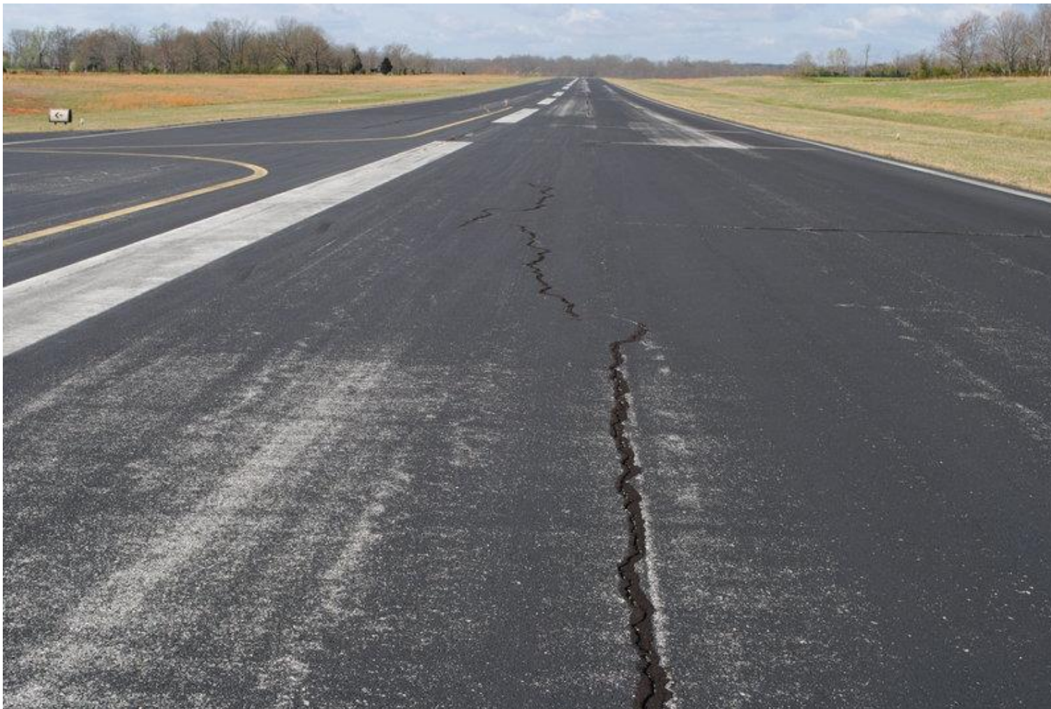
Pukotine na uzletno-sletnoj stazi
