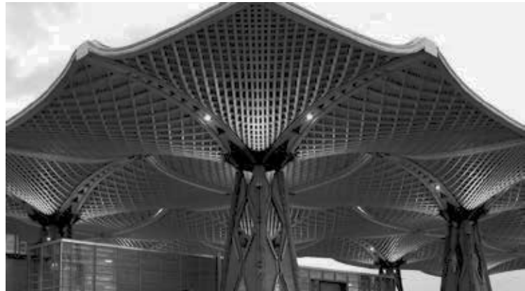
Baumstämme von Weißtannen stützen das größte freitragende Holzdach der Welt.
