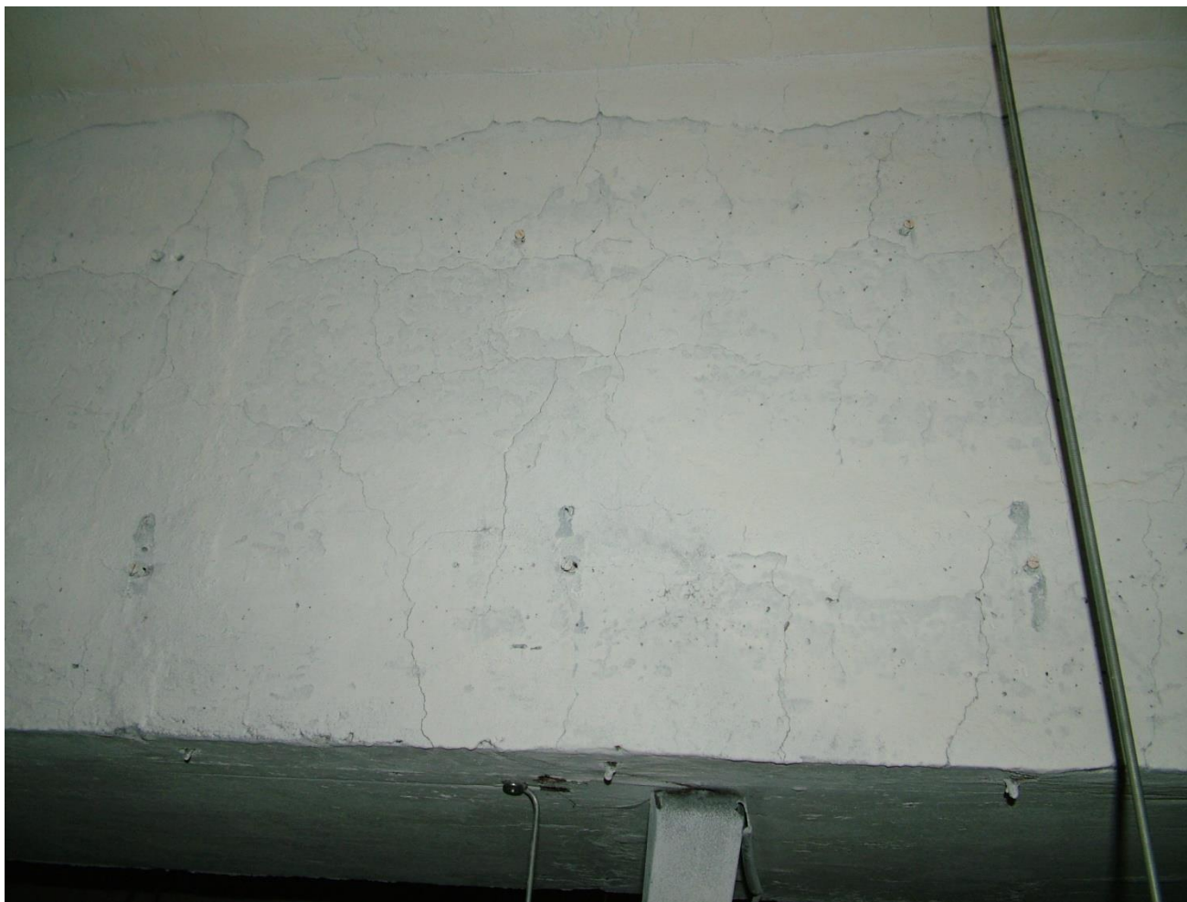
Izgled građevine stradale u požaru
