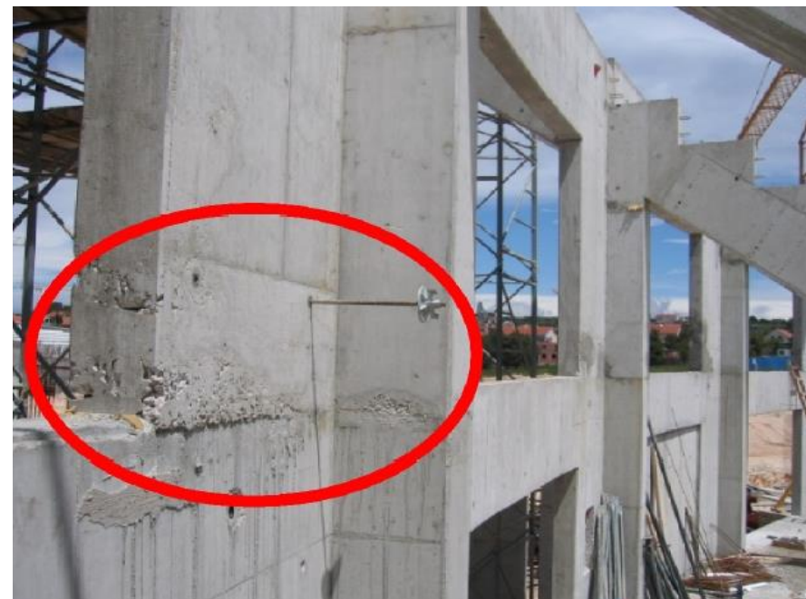
Oslabljenje konstrukcije zbog lošeg vibriranja
