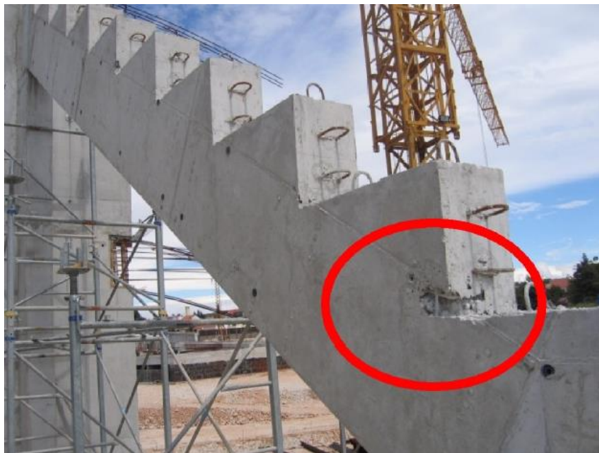
Mjesto u oplati na kojem beton nije dobro ugrađen
