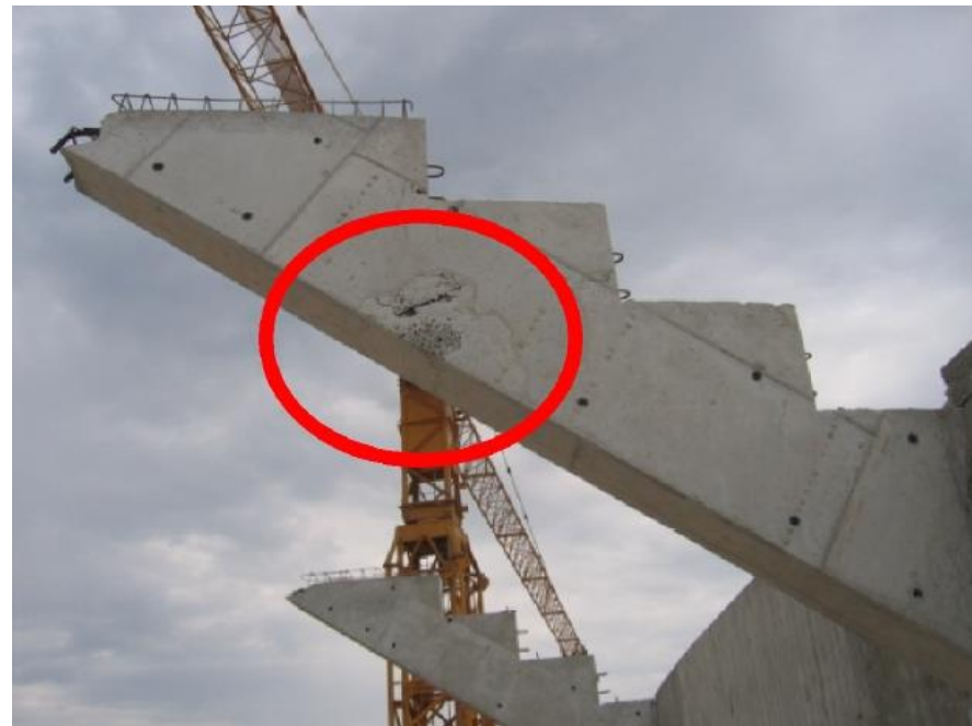
Segregacija betona i pojava “gnijezda”
