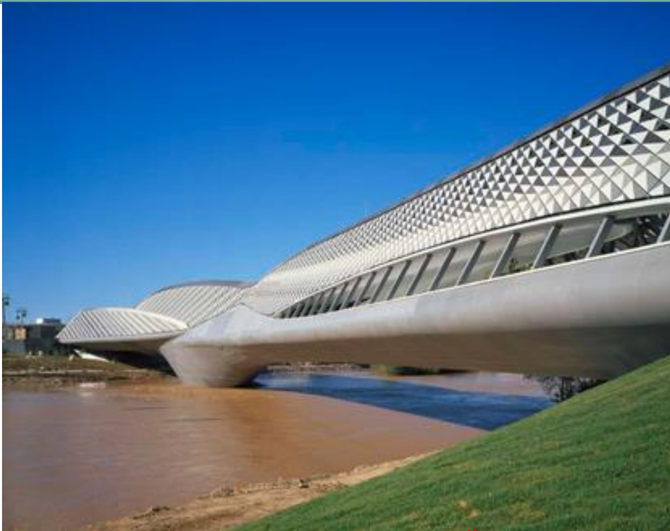
“The Bridge Pavilion” – Zaragoza, Španjolska Beton armiran staklenim vlaknima
