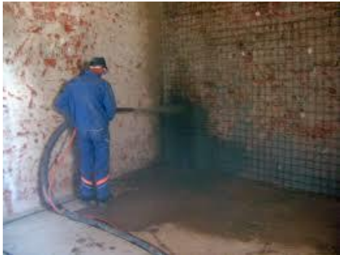
Primjer ugradnje mlaznog betona
