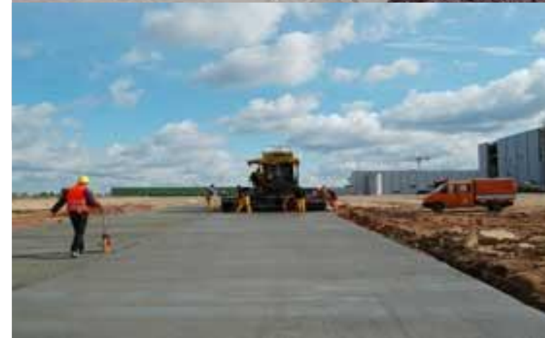
Primjena uvaljanog betona
