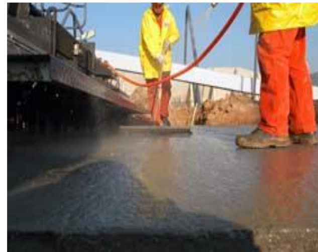
Njega uvaljanog betona
