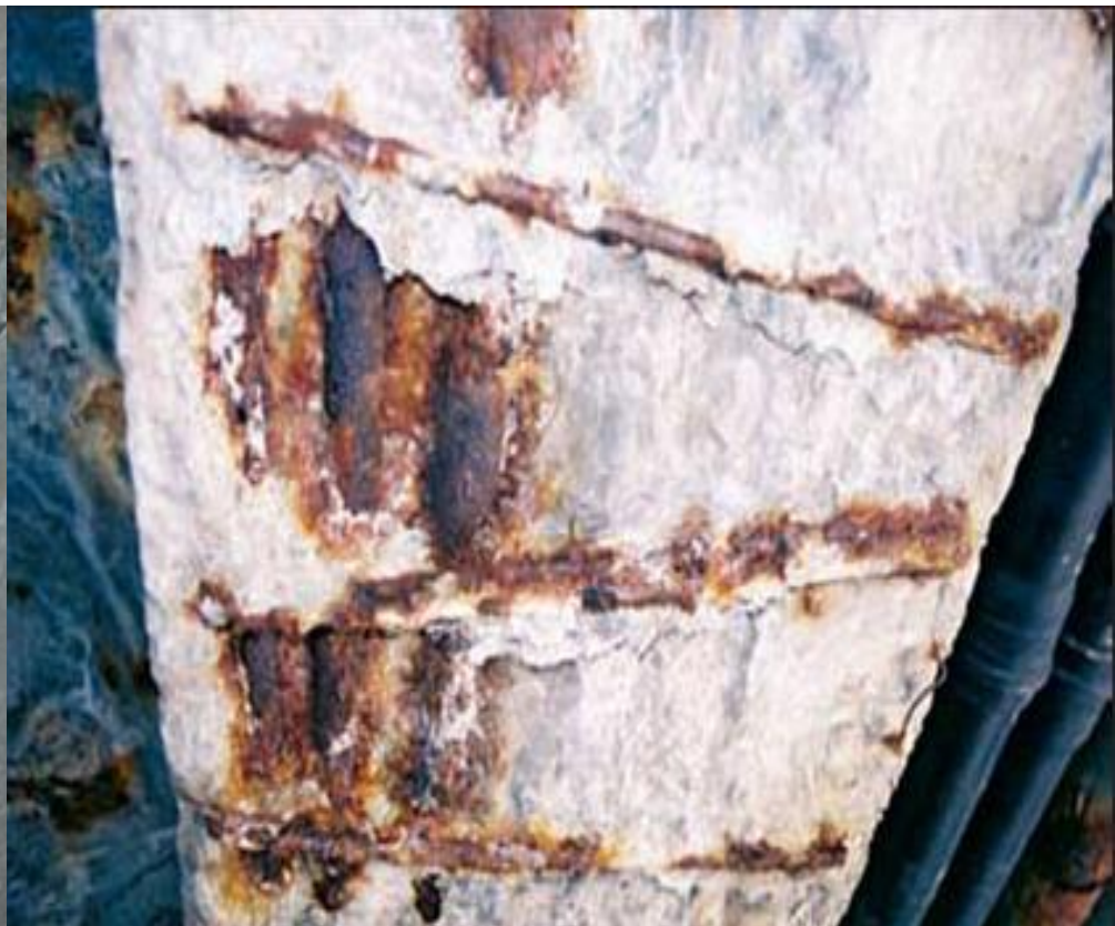
Korozija armaturnog čelika
