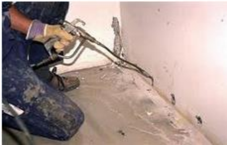
Ručno injektiranje zidova
