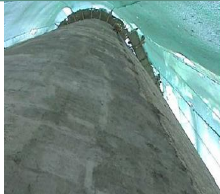
Izvedena sanacija betonske površine s mortom s dodatkom polimera
