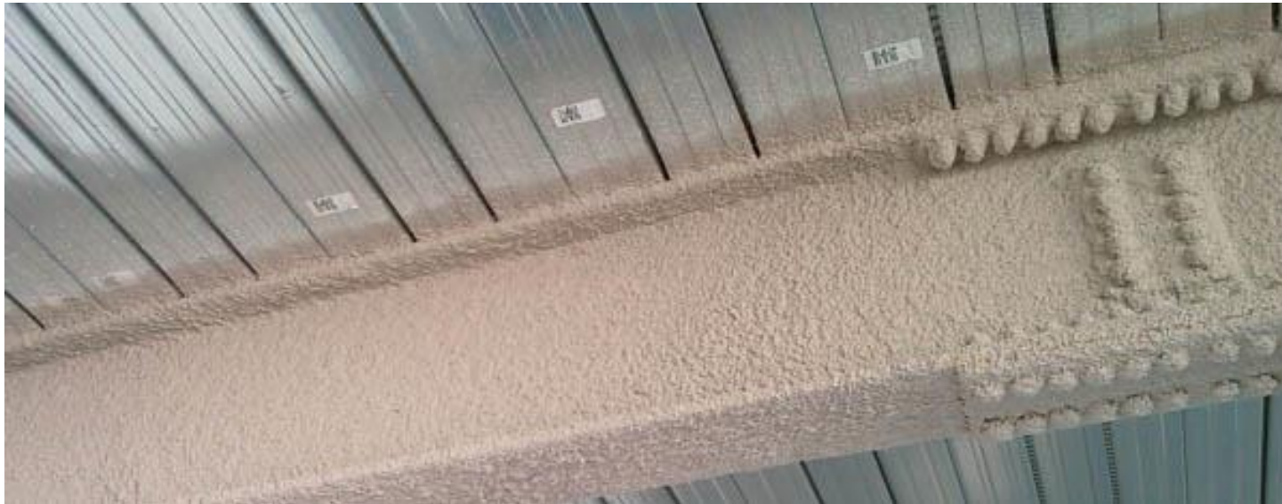
Greda obložena protupožarnim mortom
