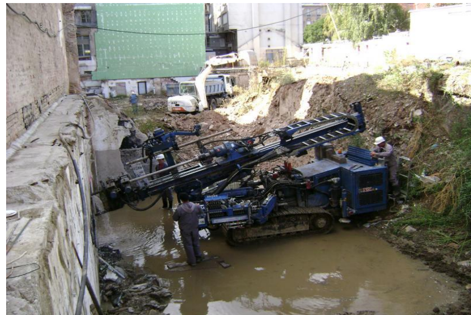
Stroj za injektiranje
