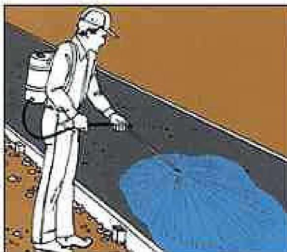
**Postavljanje mehaničke barijere i nanošenje membrane na svježi beton**
