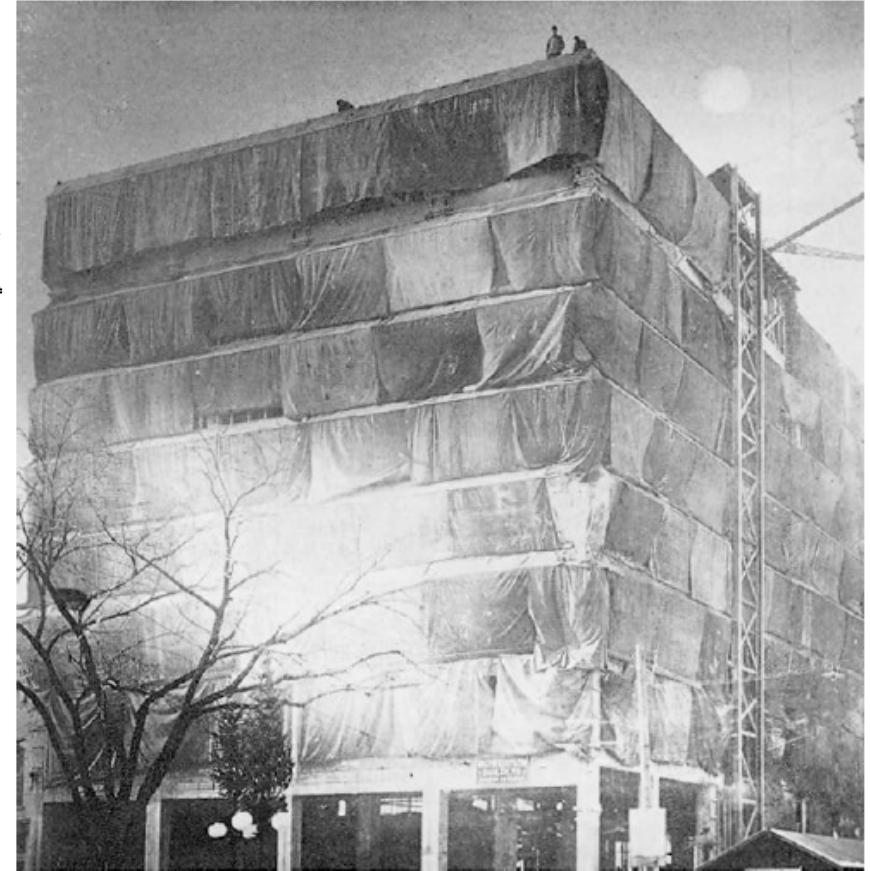
**Zaštita od niskih temperatura zraka i hladnog vjetra betoniranih elemenata s montažnom konstrukcijom** koja se premješta kako napreduje betoniranje (lijevo) i **pomoću izoloirajuće termo folije** zaštita cijele zgrade (desno)
