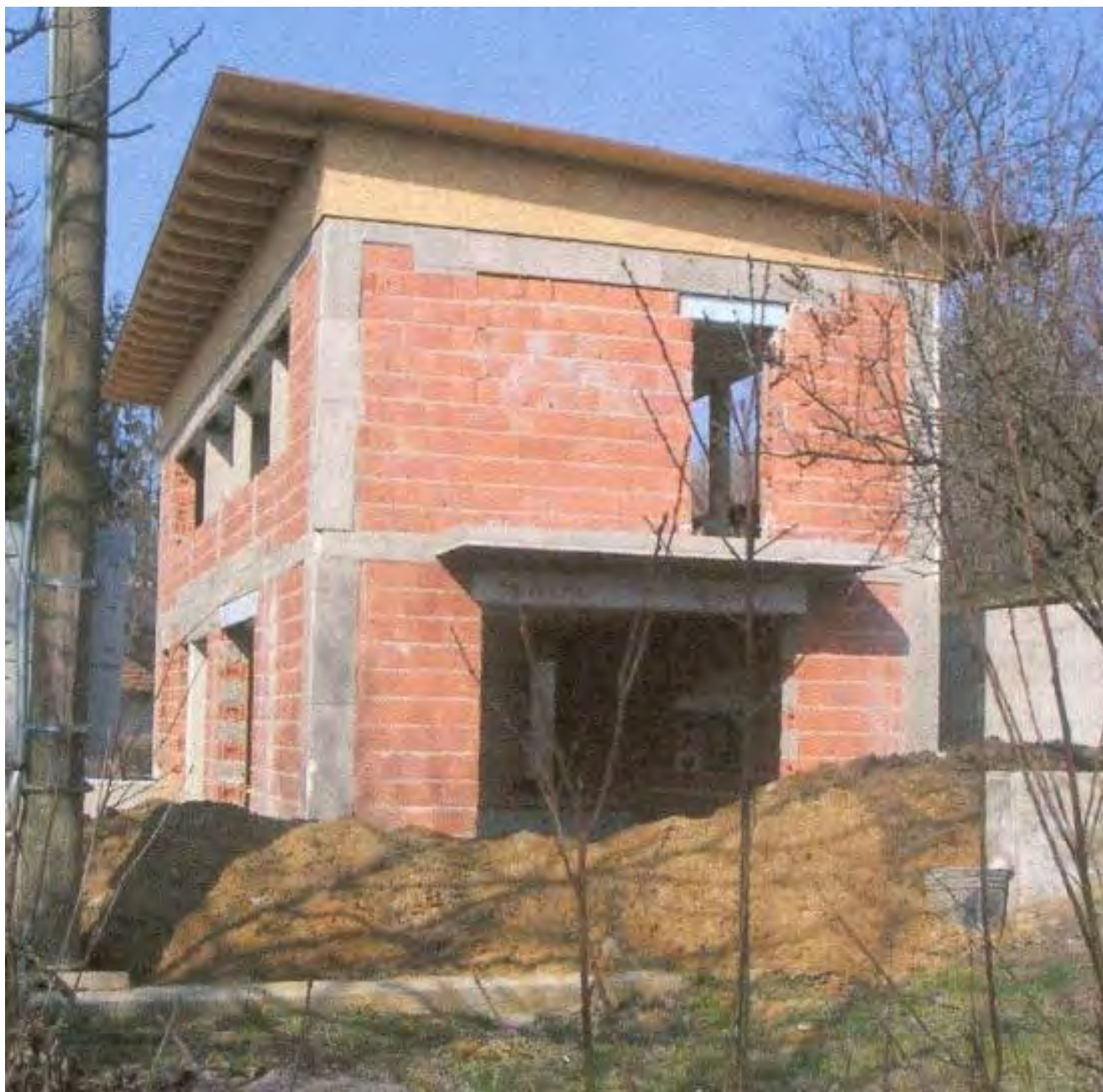
PRIMJER ZIDANE KUĆE S VERTIKALNIM I HORIZONTALNIM SERKLAŽIMA
