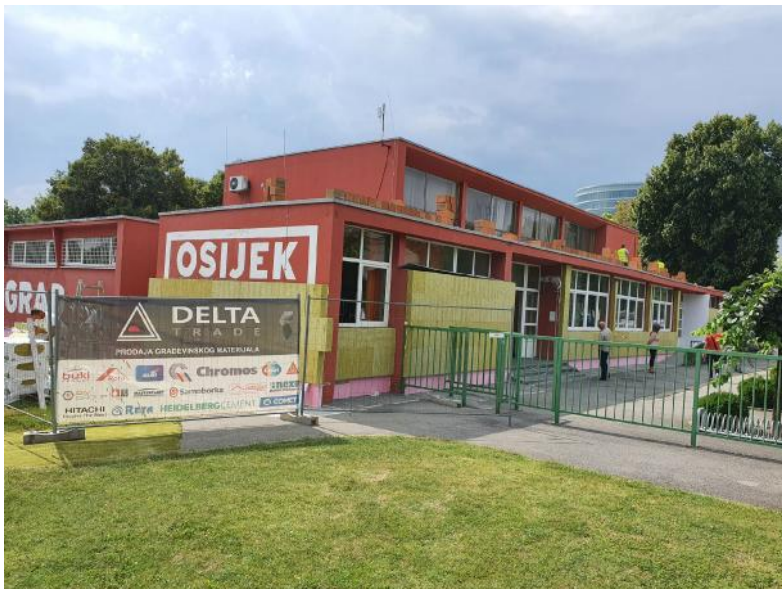
Građevinski materijal je spreman, a radnici već rade punom parom.
