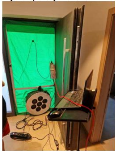
Slika 6. Sustav za upuhivanje i ispuhivanje zraka montiran na vanjski otvor zgrade
