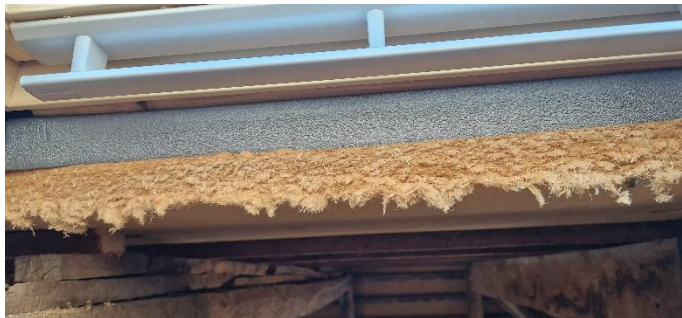
Befestigung der Heraklith BM-W Platte, 50 mm mit Holzbauschrauben, Länge 80 mm.
