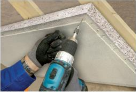
Befestigung der Heraklith BM-W Platte, 50 mm mit Holzbauschrauben, Länge 80 mm.
