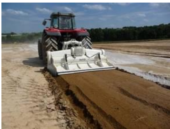
Slika 6. Postupak stabilizacije tla vapnom
