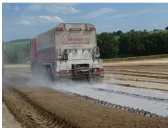
Slika 6. Postupak stabilizacije tla vapnom
