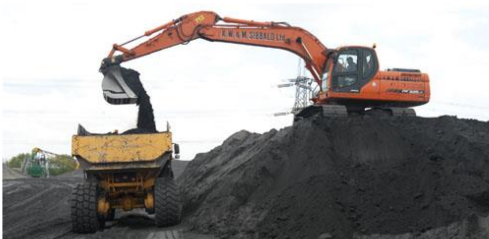
Slika 7. Utovar elektrofilterskog pepela za poboljšanje tla
