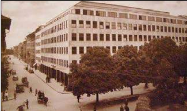
Juraj Denzler, 1933., Upravna zgrada Gradskih poduzeća (Elektra), Gundulićeva 32 / Hebrangova ul., Zagreb
