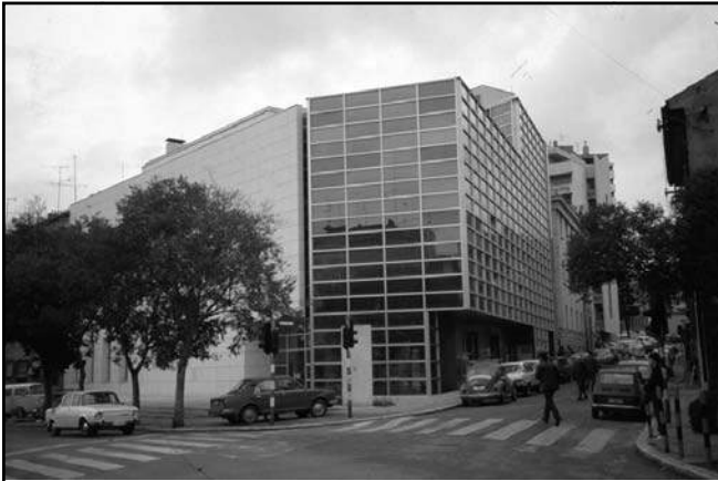
1983., Dražen Posavec, Zgrada pošte i telekomunikacija, Šibenik
