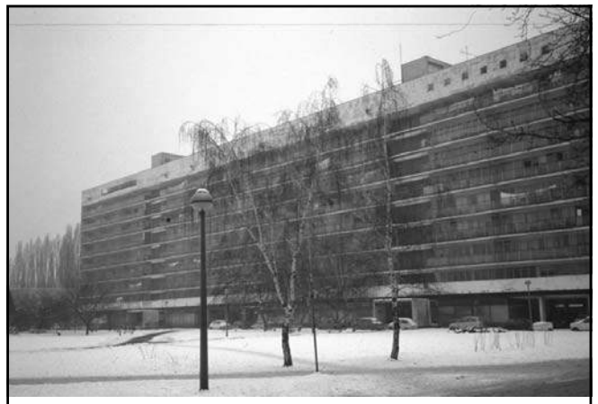
1964., Branko Raos / Slavko Jelinek, Stambena zgrada, Trešnjevka, Zagreb
