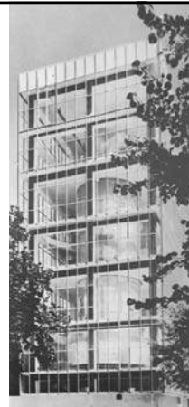
1960., Vjenceslav Richter / Josip Tešija, Pogonska zgrada tvornice Saponia, Osijek
