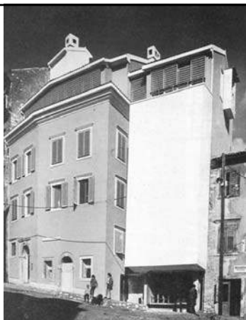
1970., Igor Emili, Poslovna zgrada Građevnog projektnog zavoda, Rijeka
