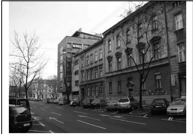
1953., Drago Galić, Stambena zgrada, Zagreb
