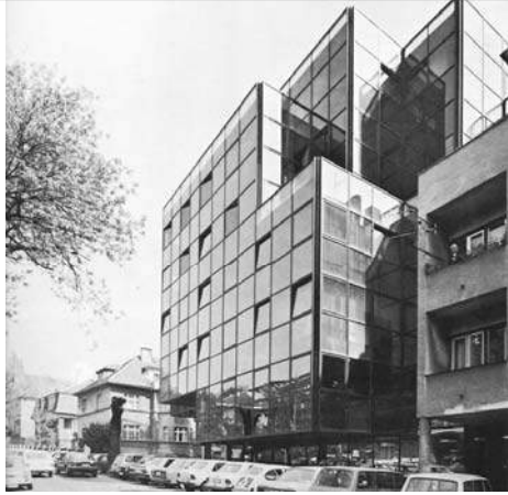
1968.-1983., Grujo Golijan, Stambeno-poslovna zgrada, Zagreb
