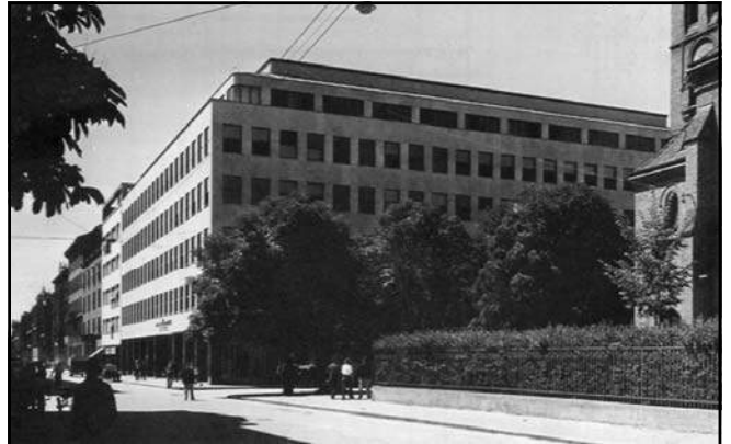
1933., Juraj Denzler, Upravna zgrada Gradskih komunalnih poduzeća, Zagreb
