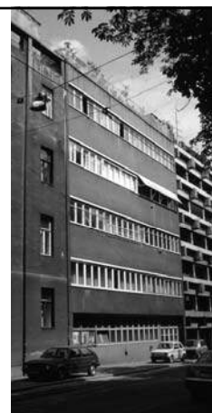
1937., Drago Ibler, Najamna zgrada Markulin, Zagreb
