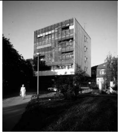
1960., Boris Krstulović, Stambena zgrada, Zagreb
