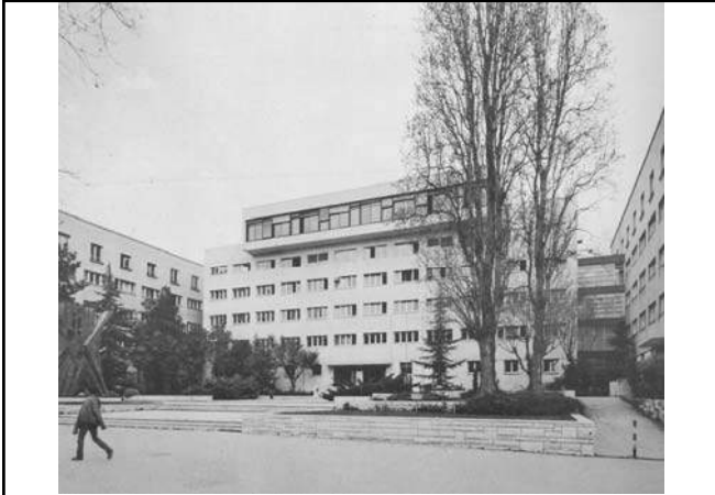
1951., Marko Markovina / Budimir Pervan, Zgrada Općine, Split
