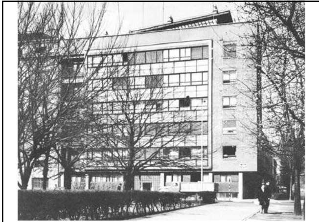
1953., Drago Galić, Stambena zgrada, Zagreb
