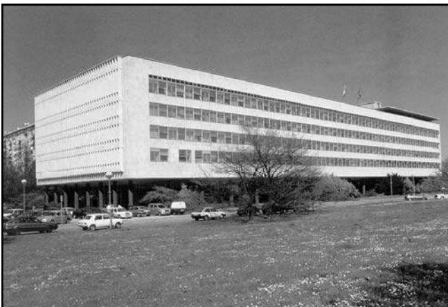
1955.-1960., Kazimir Ostrogović, Zgrada Gradske vijećnice, Ulica grada Vukovara, Zagreb
