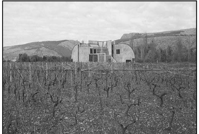
1983., Ivan Crnković, Obiteljska kuća Drodujčić, Proložac
