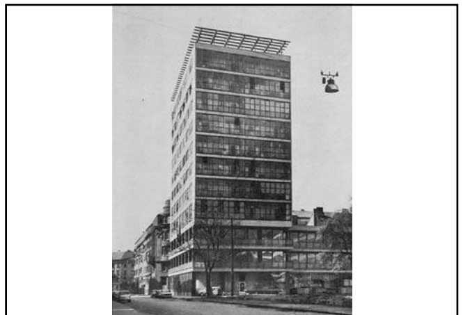
1958., Drago Ibler, Stambeno-poslovna zgrada, Zagreb
