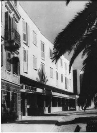
1958., Božidar Rašica, Stambeno-poslovna zgrada, Makarska
