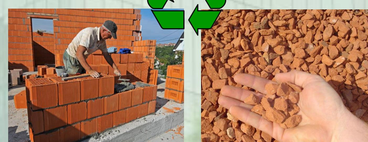
Recikliranjem opeke moguće je dobiti materijal za proizvodnju zidnih elemenata, laganog betona, betona, drenažne slojeve i nasipavanje terena.
