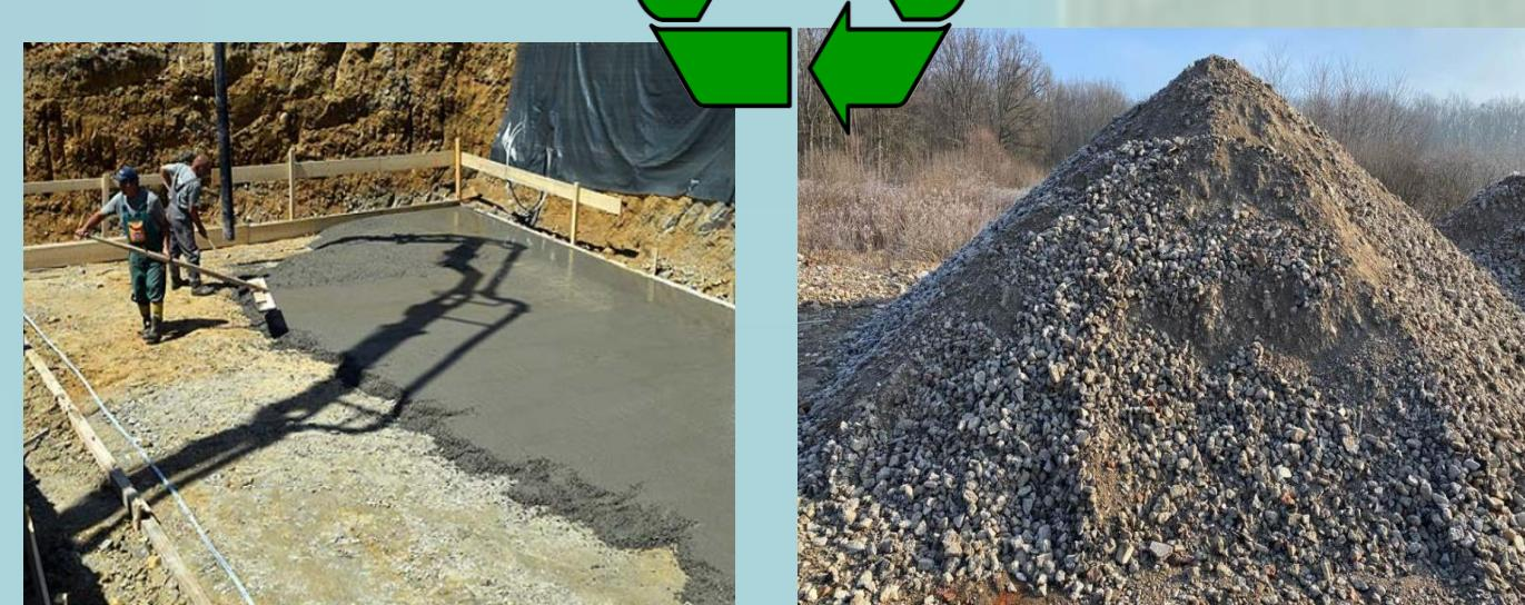
Beton od recikliranog agregata nastaje rušenjem građevina te se može iznova primijeniti kao agregat, podložni beton, podne ploče, estrih, beton za pad i sl.
