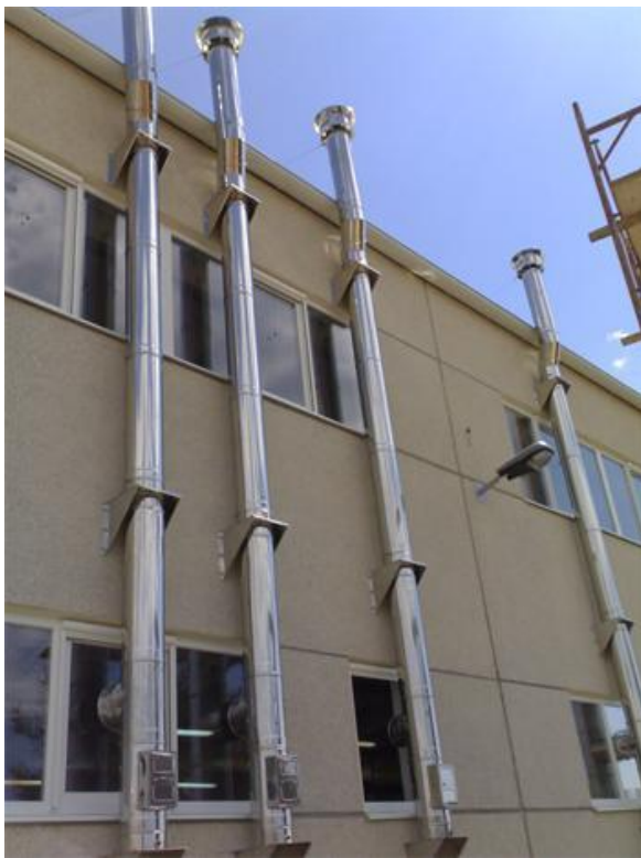
Prislonjeni dimnjak pekarnice
