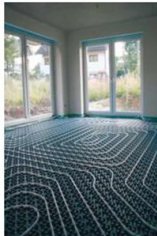
Postavljanje razvoda za podno grijanje
