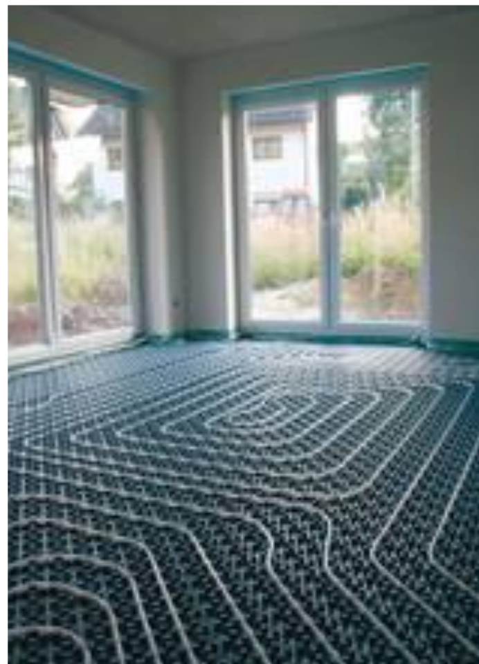
Primjer postavljanja cijevnog razvoda podnog grijanja
