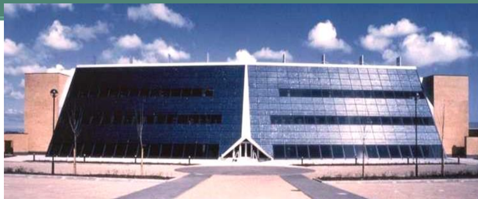
Doxford Int. PLC ured: Prva komercijalna zgrada s integriranim FN sustavom u zgradu
