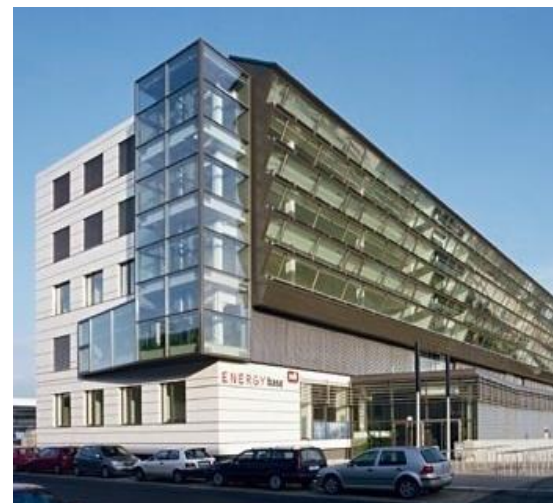
Energetski neovisna (pasivna) zgrada, Beč, Austrija
