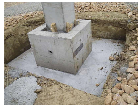
Montažna temeljna čhašica (desno s privremeno fiksiranim stupom)
