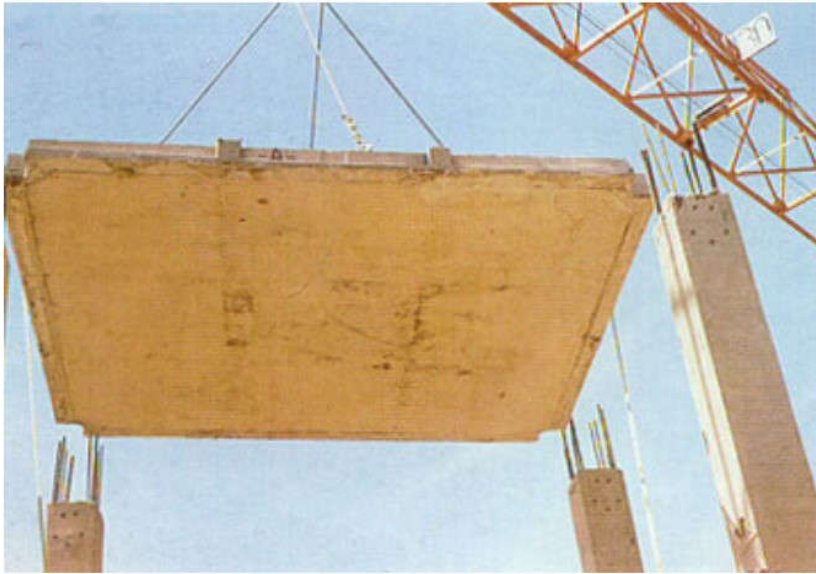
IMS stropne ploče (ispod se vide i konzolne za balkone) za stambenu visokogradnju
