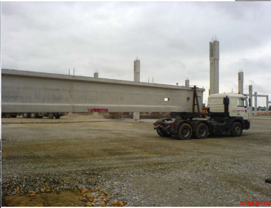
Transport montažnog nosača koji se sam oslanja na vučno vozilo i prikolicu
