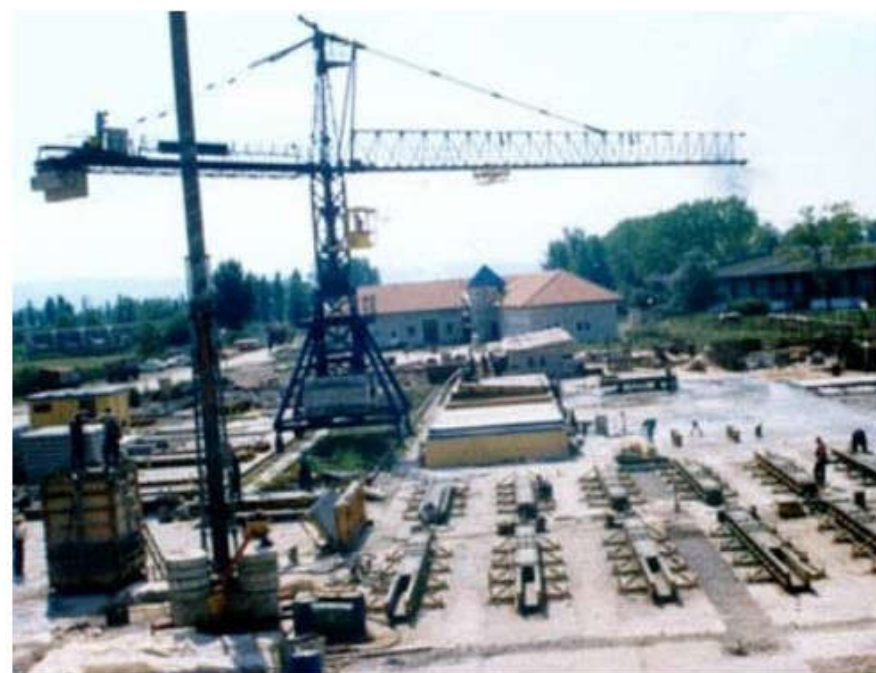
Proizvodnja IMS elemenata na otvorenim pogonima (gore) i u halama (dolje – “tvornice staniova”)
