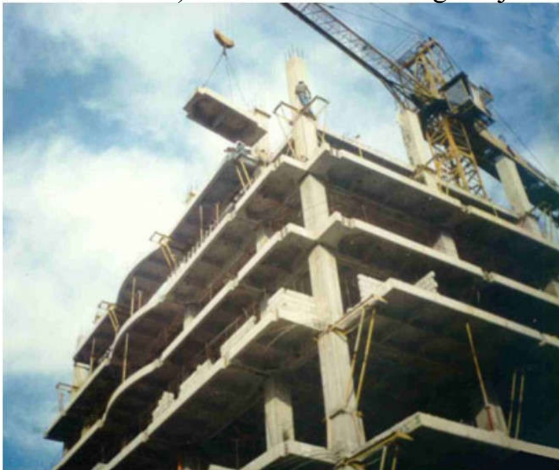
IMS stropne ploče (ispod se vide i konzolne za balkone) za stambenu visokogradnju
