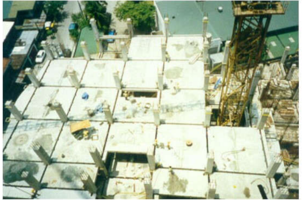
IMS stropne ploče (ispod se vide i konzolne za balkone) za stambenu visokogradnju
