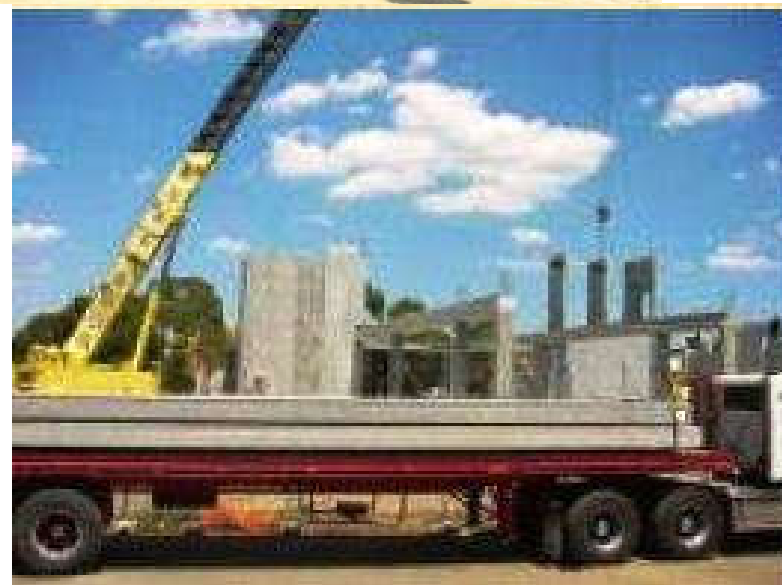
Montaža s transportnog vozila
