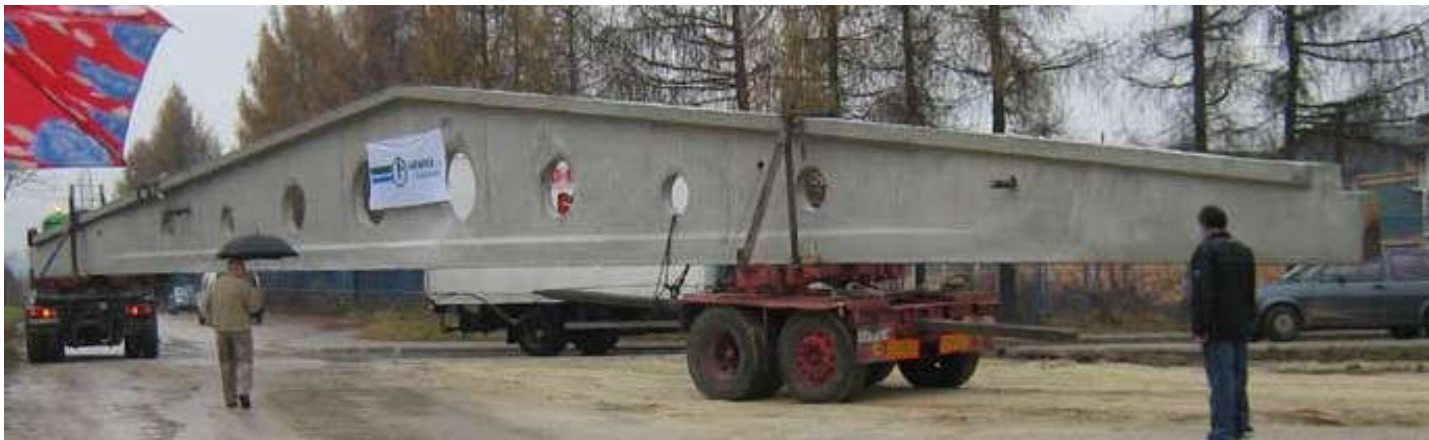
Prijevoz krovnih a.b. nosača s olakšavajućim otvorima (okomiti na uzdužne grede na stupovima)
