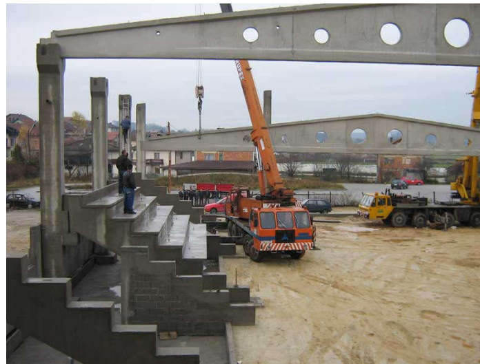
Prijenos grednih nosača hale, krovnih nosača dvorane i sanitarne kabine na mjesto ugradbe
