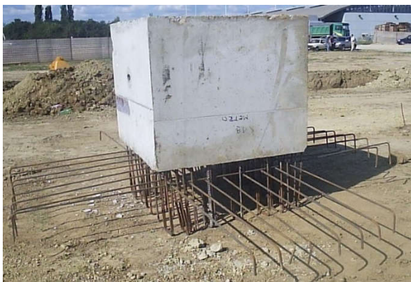
Montažna temeljna čhašica (desno s privremeno fiksiranim stupom)
