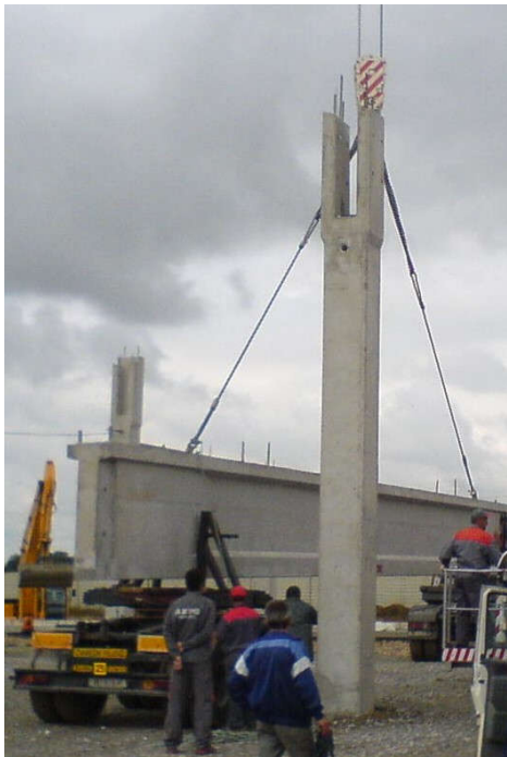
Transport montažnog nosača koji se sam oslanja na vučno vozilo i prikolicu
