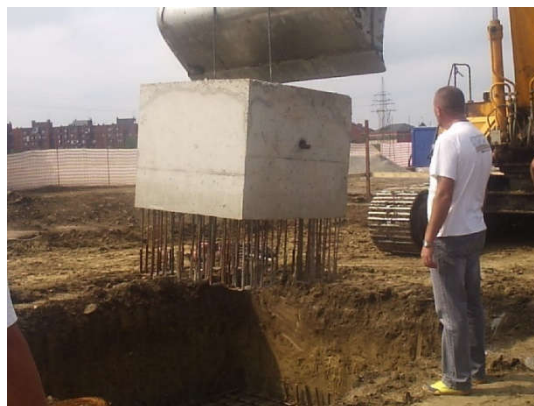
Montažna temeljna čhašica (desno s privremeno fiksiranim stupom)
