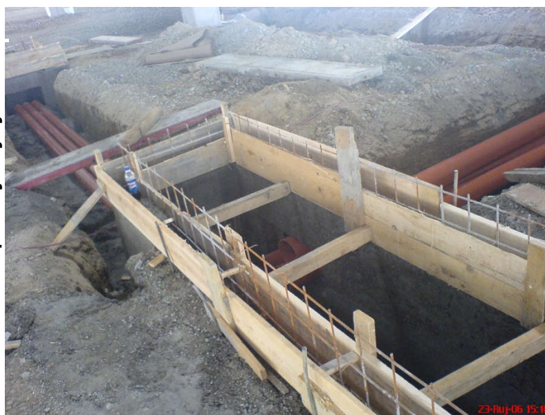
Tradicijske - dašćane oplatae, krojene na licu mjesta i danas se primjenjuju
