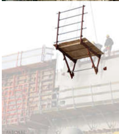
Radne staze, ograde i drugi pomoćni elementi oplatnih sustava
