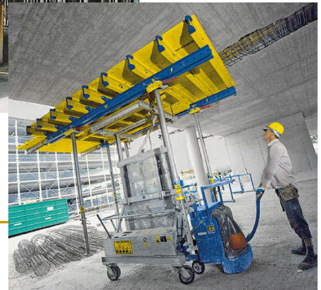
Rad s oplatnim stolovima (gore i desno premještanje uz pomoć kolica)
