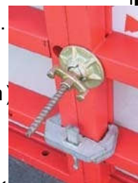
Primjeri povezivanja oplatnih elemenata na tradicijski (gore) i na suvremeni način (desno)
