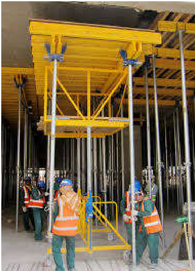
Rad s oplatnim stolovima (gore i desno premještanje uz pomoć kolica)
