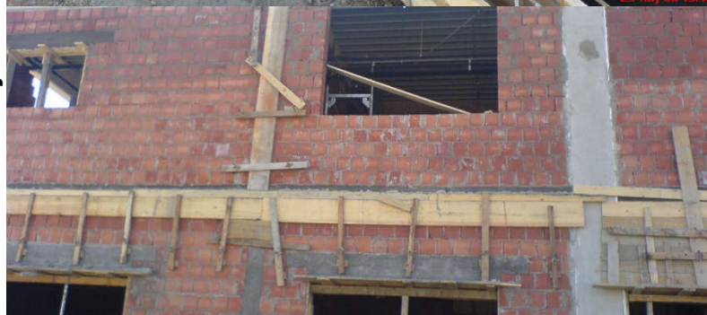
Tradicijske - dašćane oplatae, krojene na licu mjesta i danas se primjenjuju
