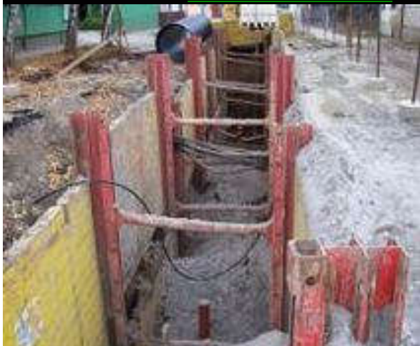
KONSTRUKCIJA PODGRADE ISKOPA
