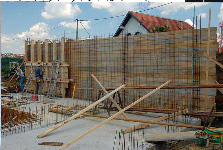
Tradicijske - dašćane oplatae, krojene na licu mjesta i danas se primjenjuju
