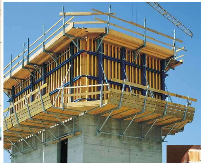
Radne staze, ograde i drugi pomoćni elementi oplatnih sustava
