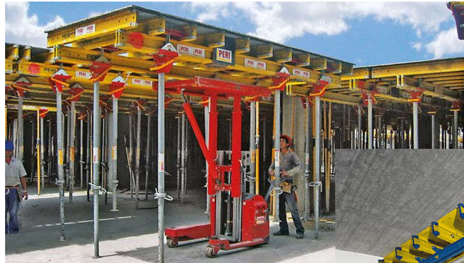
Rad s oplatnim stolovima (gore i desno premještanje uz pomoć kolica)
