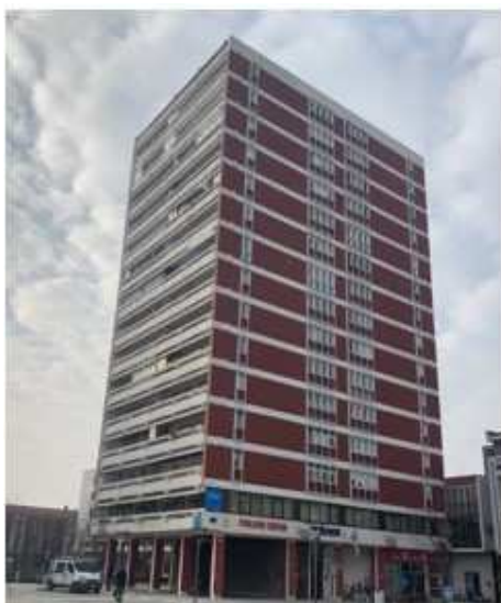
c) starija armirnobetonska zgrada (armirnobetonski okvir)
