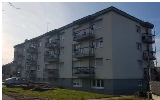
b) zgrada u Petrinji izgrađena 2015.
