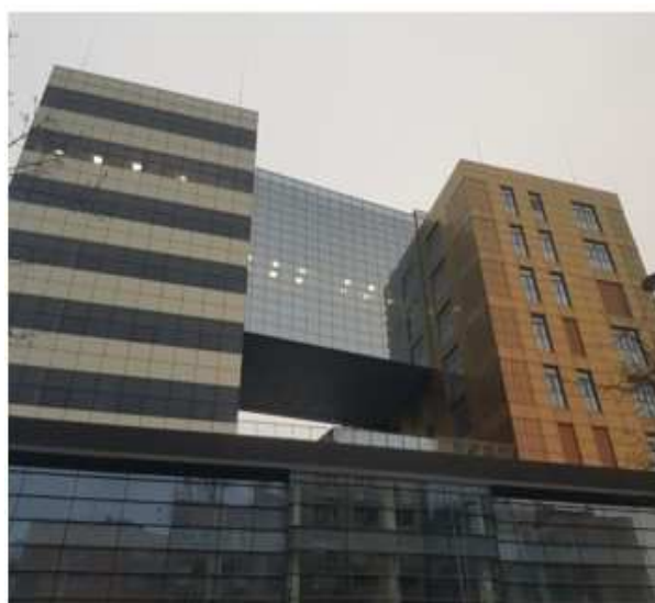
d) novija armiranobetonska zgrada (armiranobetonski okvir)
