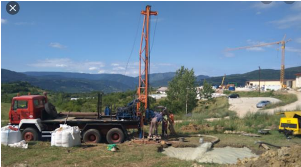
Bušenje sa bentonitnom isplakom
