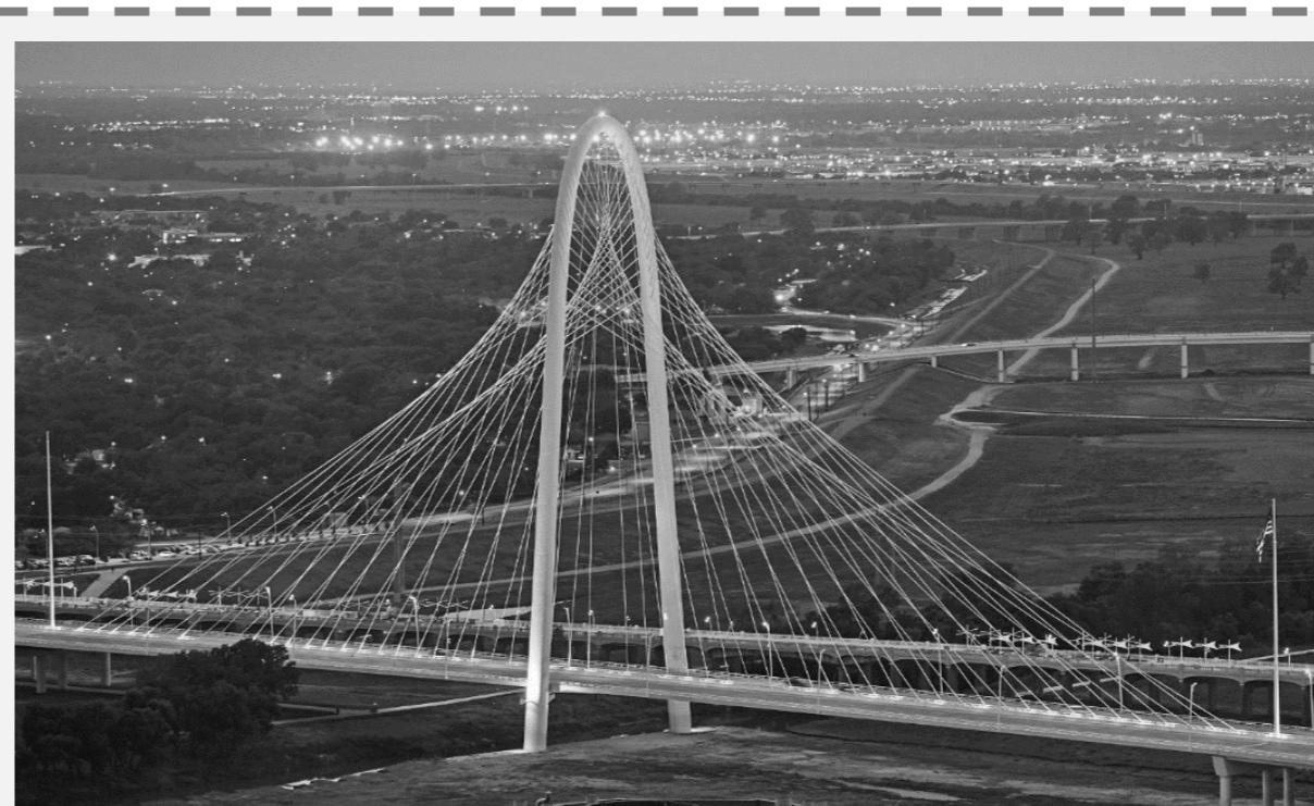
**MARGARET HUNT HILL BRIDGE (2010-2012)** je smješten u Dallasu. Dug je 368 metara i širok 36,7 metara. Blještavo bijeli čelični luk čini parabolični pilon ukupne visine 136 m i mrežom kablova pridržava rasponski sklop.
