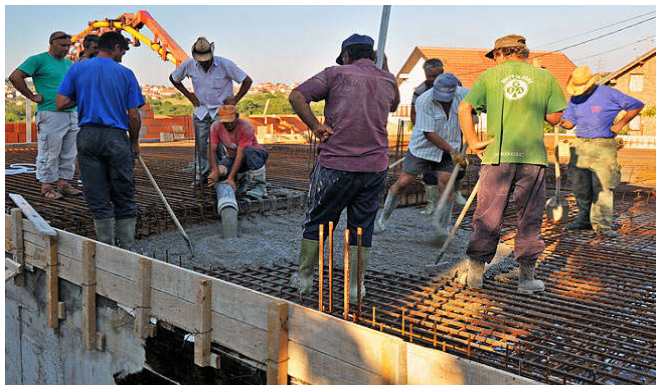
Uobičajene situacije kod ugradbe betona
