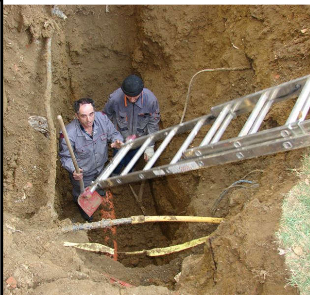
Iskop rovova za cijevi
