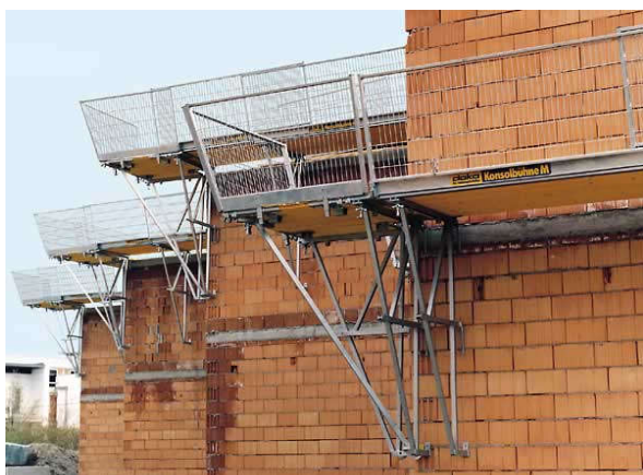
Konzolna skela od tipskih, tvornički proizvedenih elemenata
