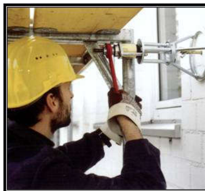
Pričvršćenje - sidrenje skele za objekt
