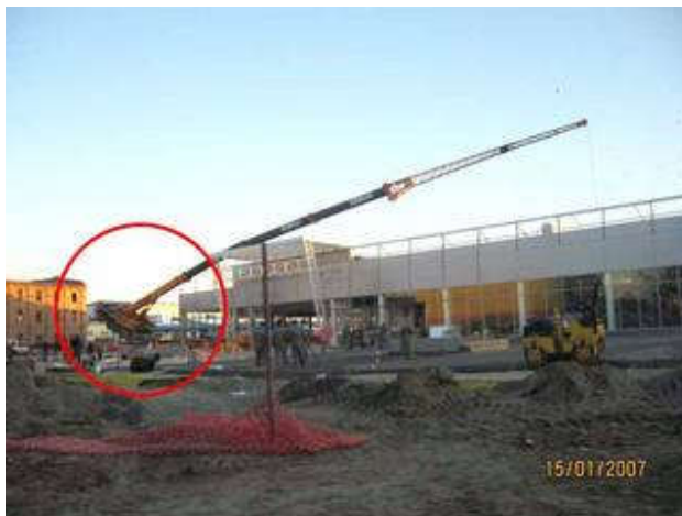
Mobil. dizalica nagnuta zbog preopterećenja pri gradnji Interšpara u Osijeku 2007. godine
