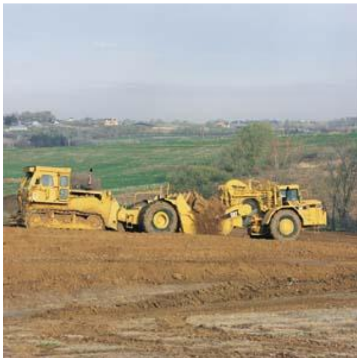
Slika 10. –Korištenje dozera kao gurača pri iskopu
