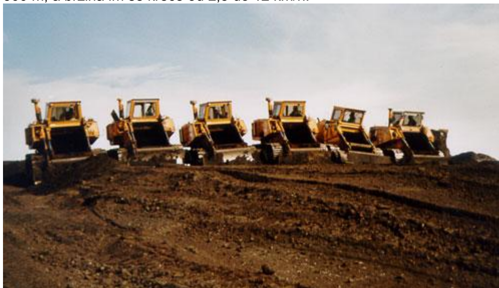
Slika 9. – "Ekipa" dozer skrejpera na gradilištu
