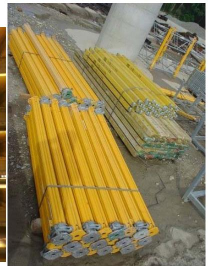
Zaštitni premazi su potrebni i ako se oplata spremi na skladište, a to je svakako potrebno učiniti barem još jednom prije zimske sezone, bez obzira jeli to već prije napravljeno. Te nešto dulje prekide u korištenju dobro je iskoristiti za pregled i popravak svih oštećenja na oplatnim elementima i maksimalno obaviti pripremu za sljedeću građevinsku sezonu.
