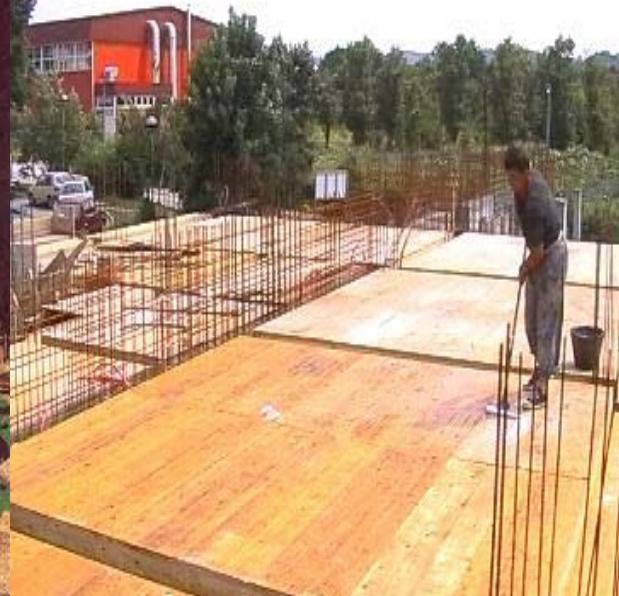
*Kako bi se izbjegao negativan utjecaj atmosferilija na oplate koje su na njih osjetljive, dobro je da što manje vremena prođe od njihove montaže do betoniranja. Čim je to vrijeme duže, u oplati se može nakupiti više otpadaka, prašine i drugih nečistoća koje obvezno treba ukloniti prije usipavanja betona.*
