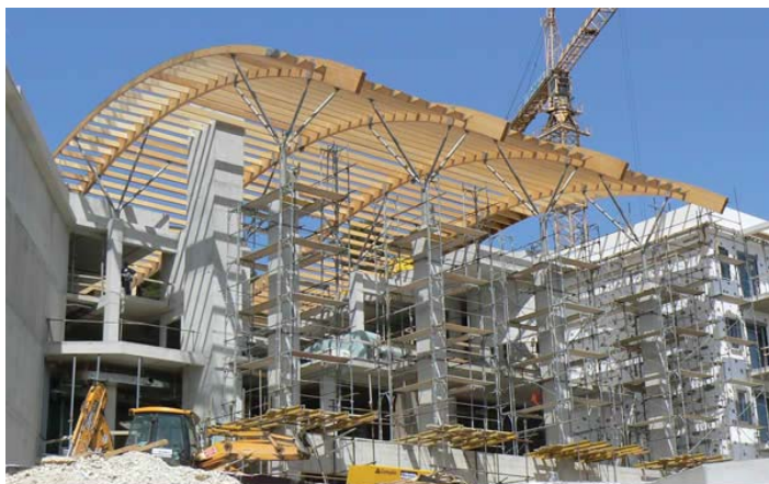
Montirani glavni i sekundarni krovni elementi
