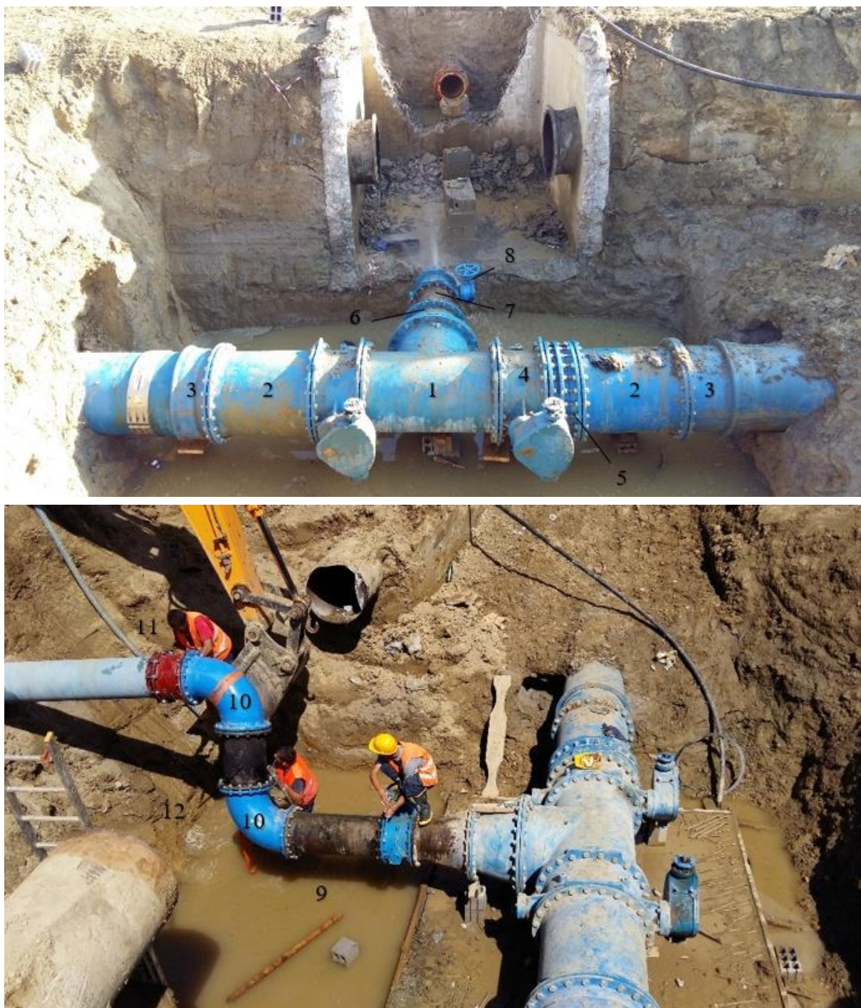
Slika 6.5 Čvorište magistralnog cjevovoda DN 800 na kojem se vrši spajanje novog cjevovoda na postojeći cjevovod DN 400
