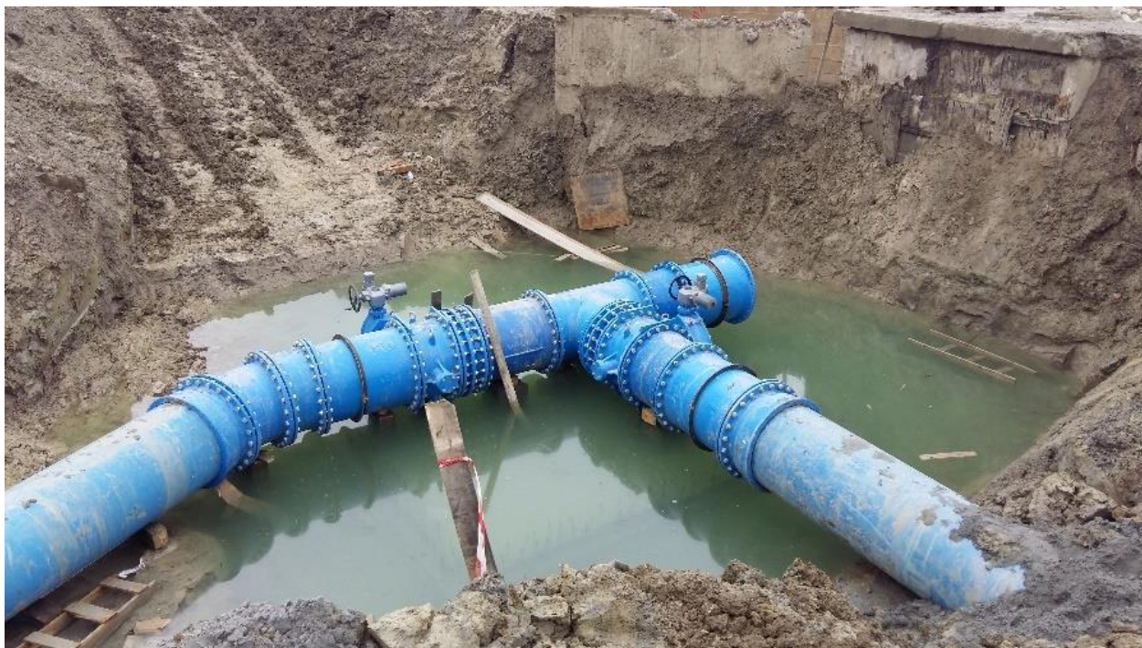
Slika 6.8 Čvorište s postavljenim fazonskim komadima i armaturama; vidljiva podzemna voda unutar građevne jame [10]
