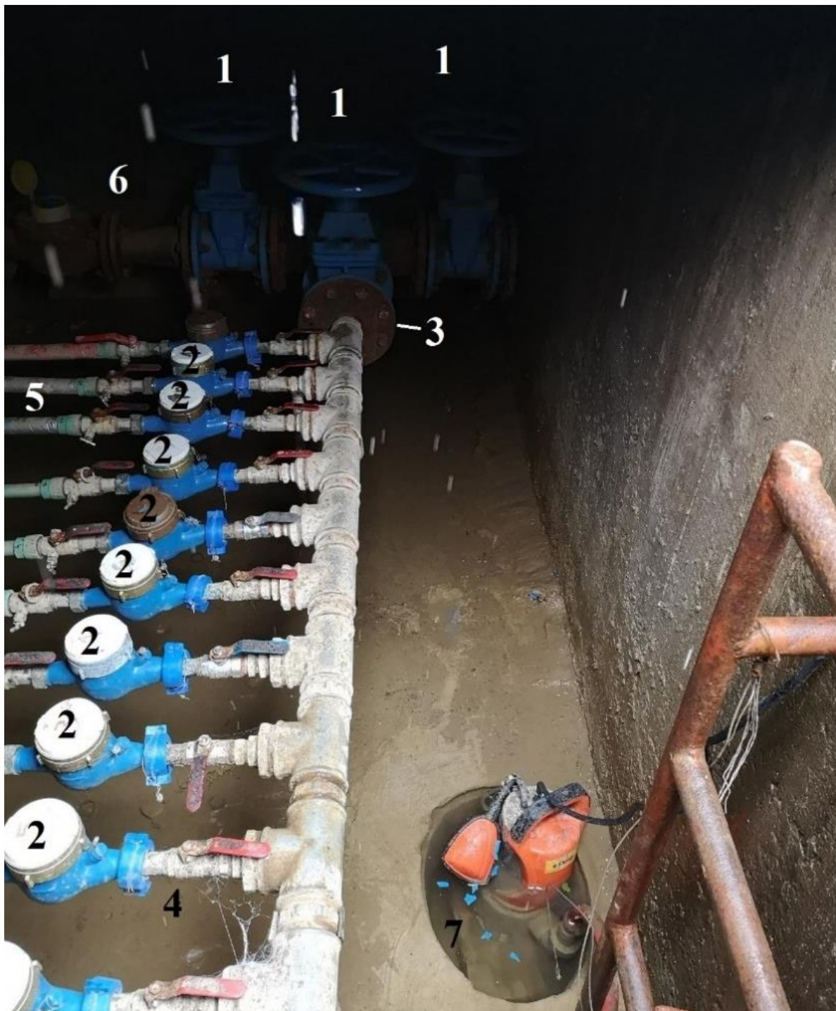
Slika 6.18 Prikaz priključnog okna u stambenoj zgradi sa zasebnim razvodom i mjeračima protoka za unutarnju hidrantsku i opskrbnu mrežu (1. EV zasun, 2. Vodomjeri, 3. Priključak za zgradu, 4. Kuglasti ventil, 5. Priključna cijev prema potrošačima DN 32, 6. Unutrašnji hidrantski vod, 7. Potopna crpka)
