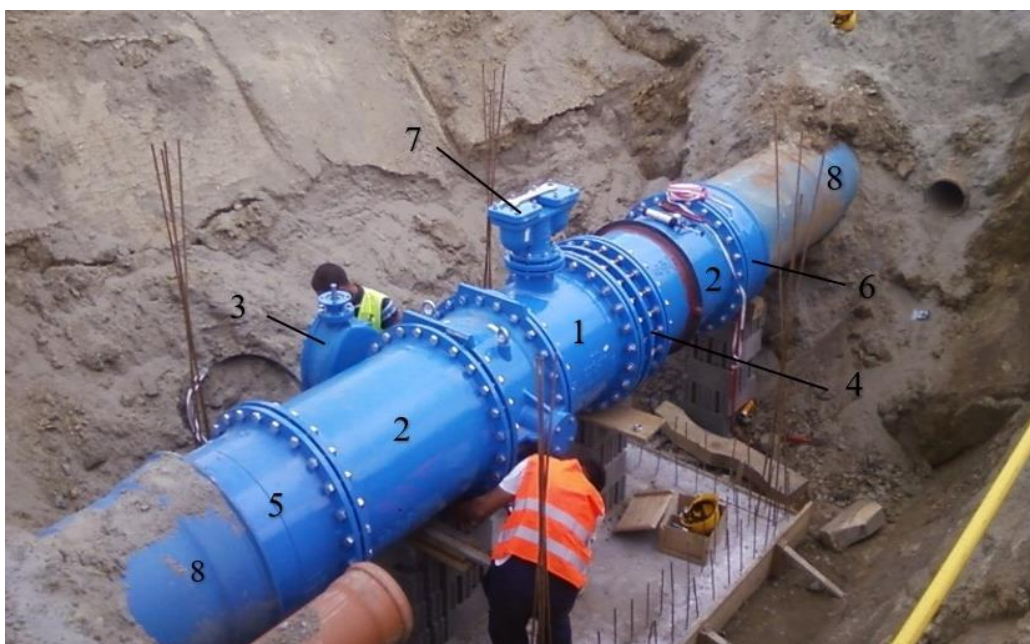
Slika 6.2 Završno slaganje fazonskih komada magistralnog cjevovoda DN 800
