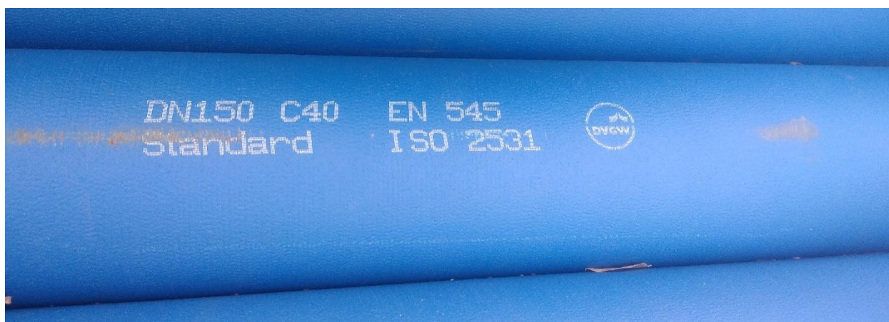
Slika 3.4 Primjer duktilne cijevi s oznakama
