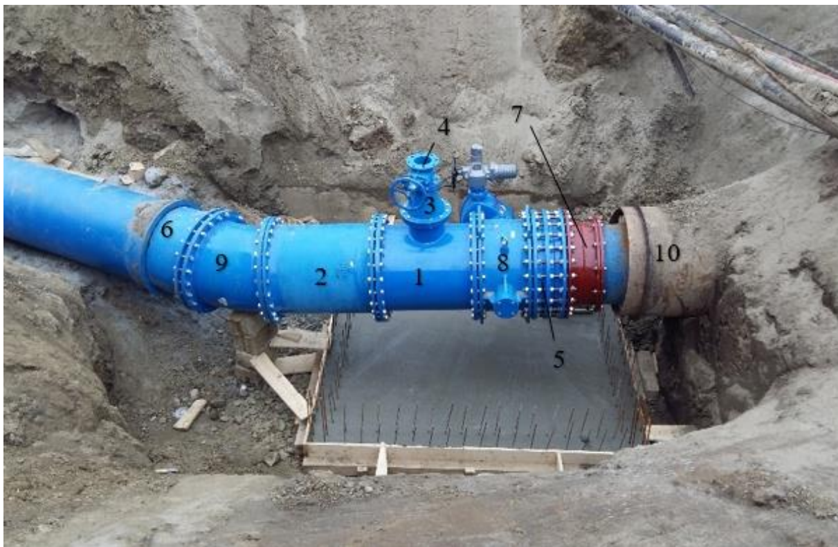
Slika 6.3 Čvorište magistralnog cjevovoda DN 800 s koljenom i zaštitnom čeličnom cijevi izvan okna (1. T komad DN 800/300, 2. FF komad DN 800 L= 1000 mm, 3. FFR komad DN 300/150, 4. EV zasun DN 150, 5. MDK komad DN 800, 6. F komad DN 800, 7. E komad ST system (prirubnička spojnica / redukcija za duktil DN 800 / DN 700), 8. Leptirasti zatvarač s el. motornim DN 800, 9. FFK komad DN 800 22 1 / 2 , 10. Zaštitna čelična cijev s distancerima) [10]
