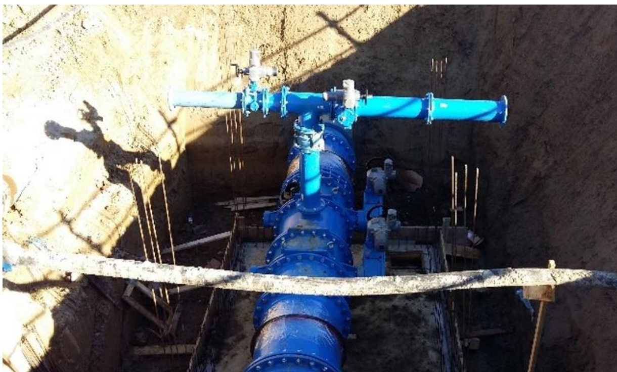
Slika 6.4 Čvorište magistralnog cjevovoda DN 800 s postavljenim fazonskim komadima i armaturama (betonirana donja ploča i pripremljena armatura za zidove okna) sa spojem na opskrbi cjevovodu (DN 200). Iznad glavnog voda vidljiv je priključak (vertikalna cijev) za ogranke na vodoopskrbnoj mreži s postavljenim leptirastim zasunom na početku pojedinog ogranka [10]
