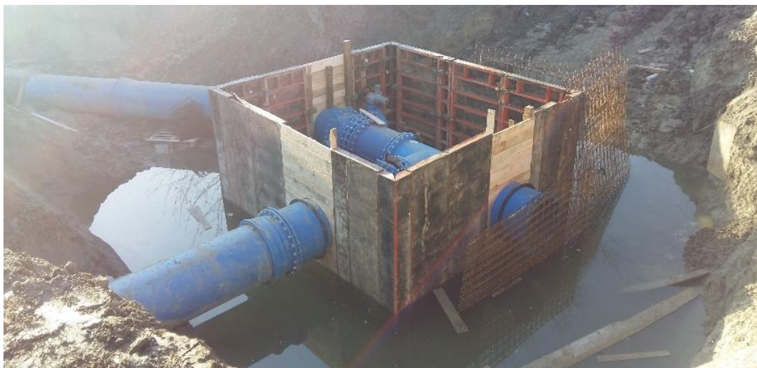
Slika 6.10 Čvorište s postavljenim fazonskim komadima, armaturama i pripremljenom oplatom; vidljiva podzemna voda unutar građevne jame uslijed gašenja crpke za snižavanje podzemnih voda [10]
