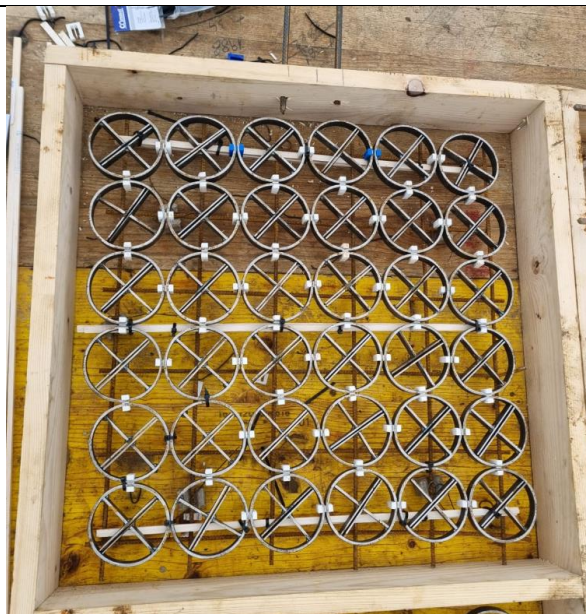
Slika 6. Postupak izrade betonskog bloka s PPS
