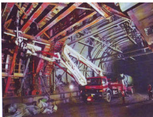
Slika br. 42 Mobilna pumpa M 24-4 za rad u tunelima
