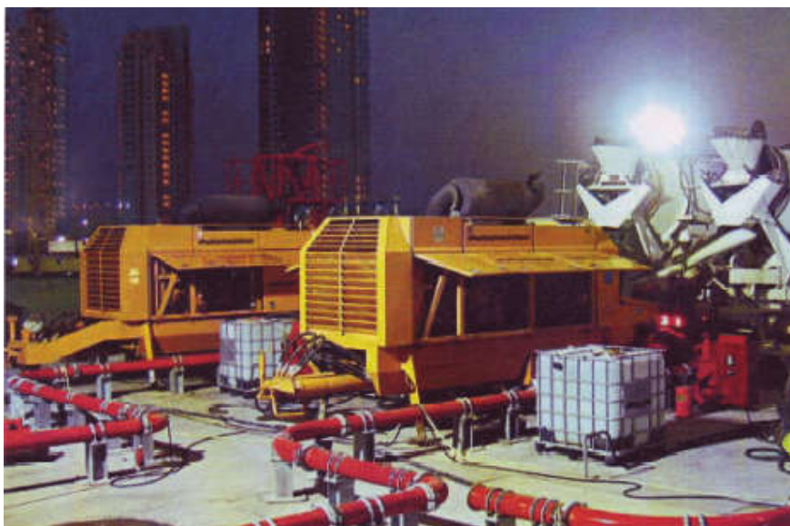
Slika br. 31. Stacionarna beton pumpa
