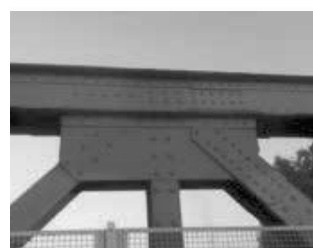
Knotenblech an einer Stahlkonstruktion
