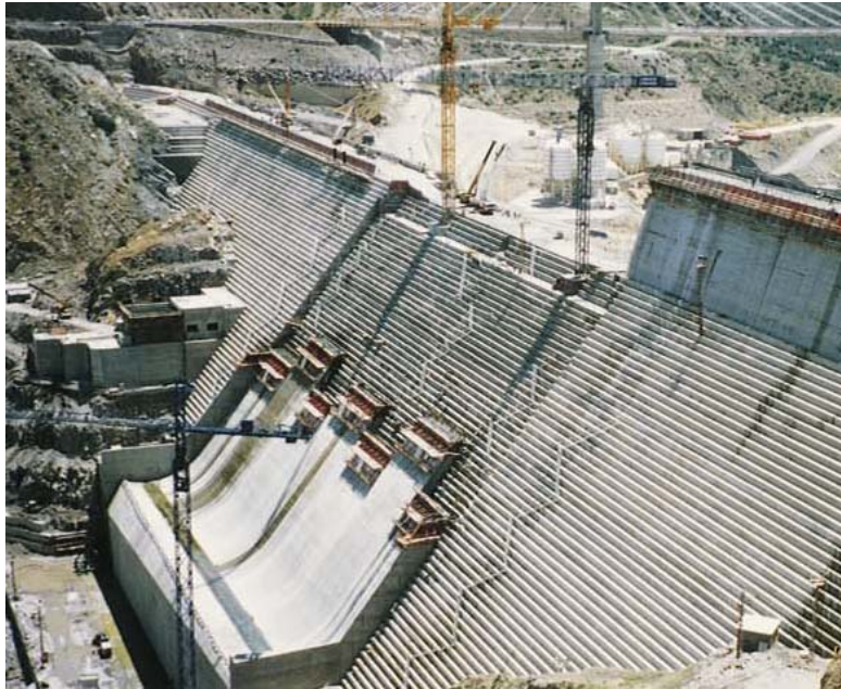
Slika: -Izvedba zida brane
