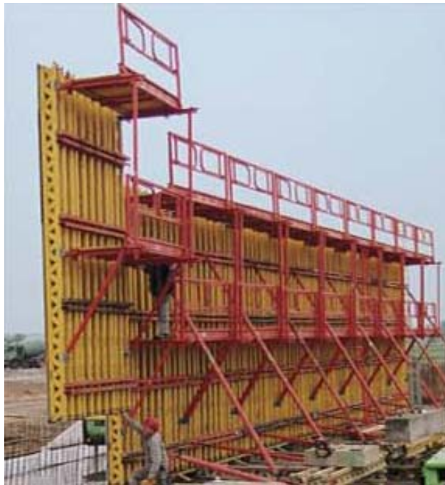
Slika: -Velikoplošni oplatni sklop s radnom stazom
