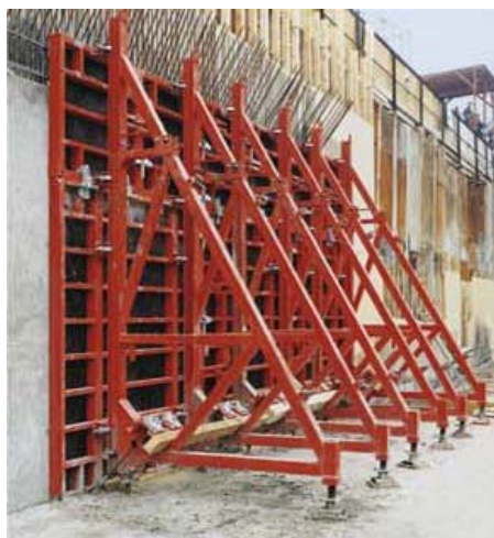
Slika: -Jednostrane, velikoplošne zidne oplata
