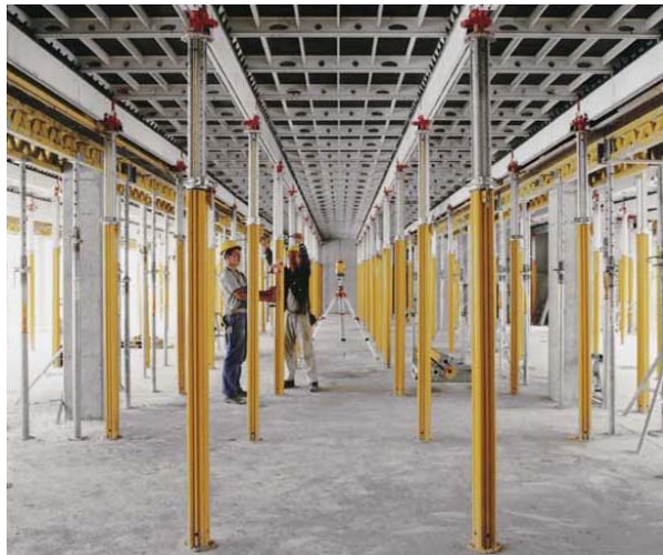
Podupiranje stropne oplata
