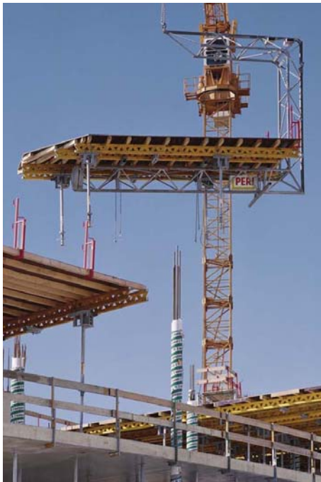
Slika -Transport oplatnog stola dizalicom
