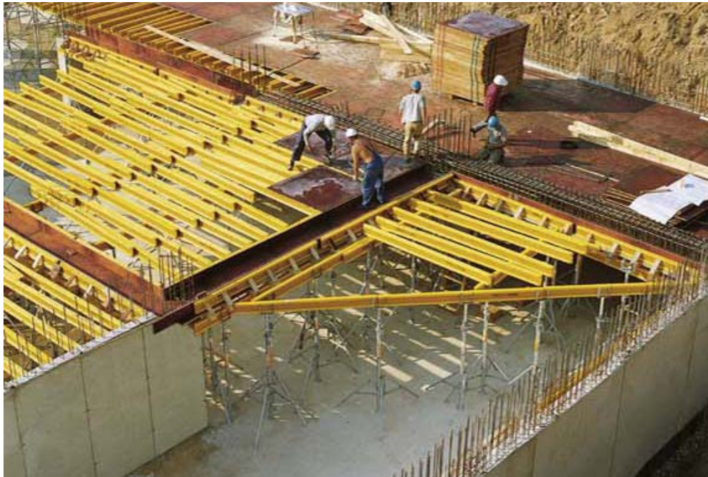
Slika: -Postavljanje oplatnih ploha na nosive konstrukcije
