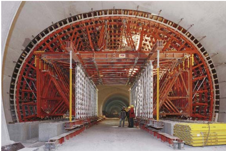
Slika –Oplata kod tunelogradnje
