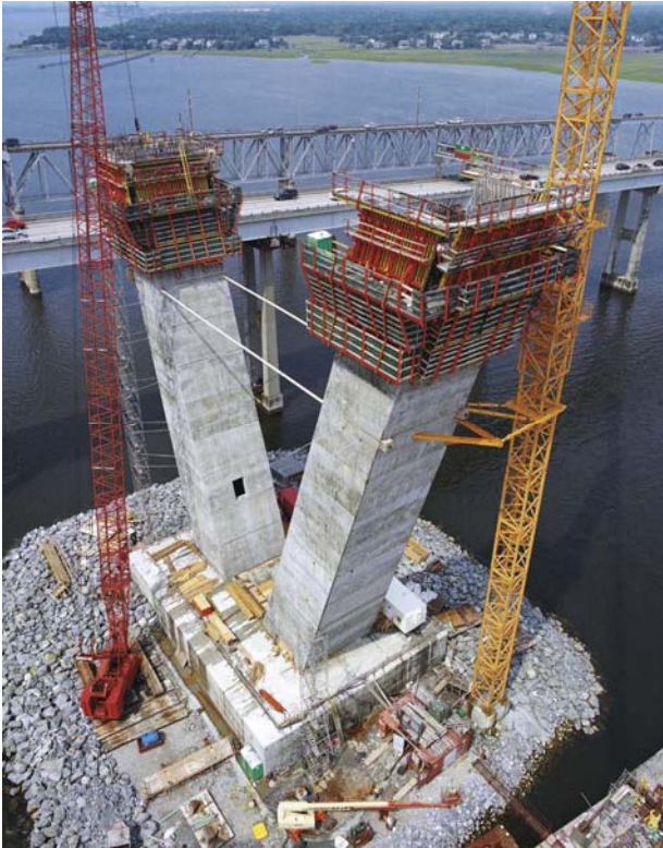
Slika: -Oplata visokih stupova mostova
