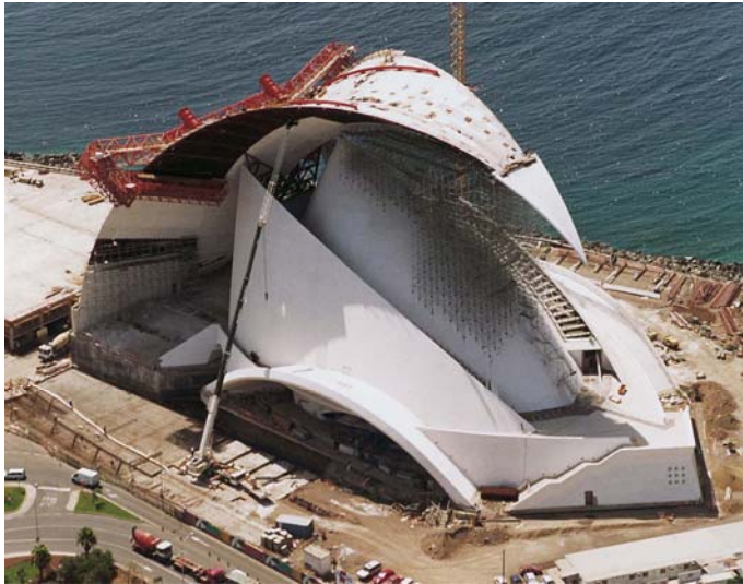
Slika: - Primjer složene građevine koja zahtjeva komplicirane oplatne sklopove
