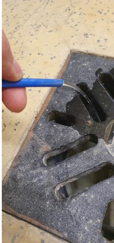
Slika 9.1 Provjera protoka vode kroz sustav
