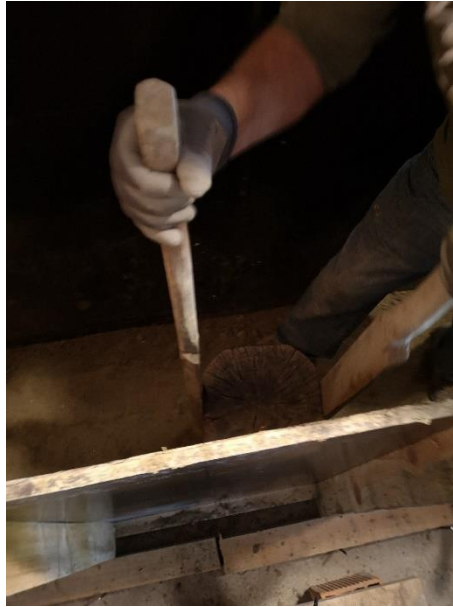
Slika 2.8 Zbijanje sloja zemlje drvenim nabijačem
