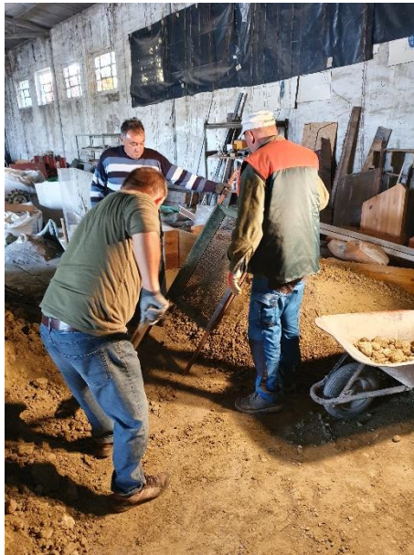
Slika 2.3 Prosijavanje zemljanog materijala
