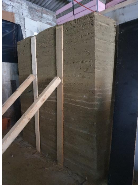
Slika 2.10 Pridržavanje zida kosnicima nakon skidanja oplata
