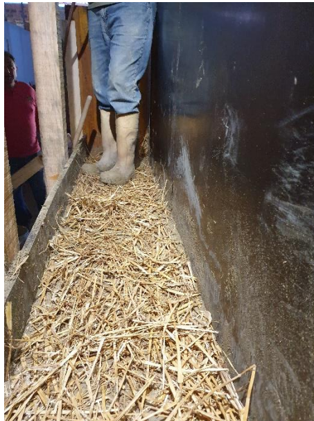
Slika 2.9 Nasipavanje sloja slame na dva zbijena sloja zemlje
