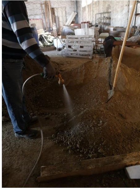
Slika 2.4 Vlaženje zemljanog materijala sitnim kapljicama vode
