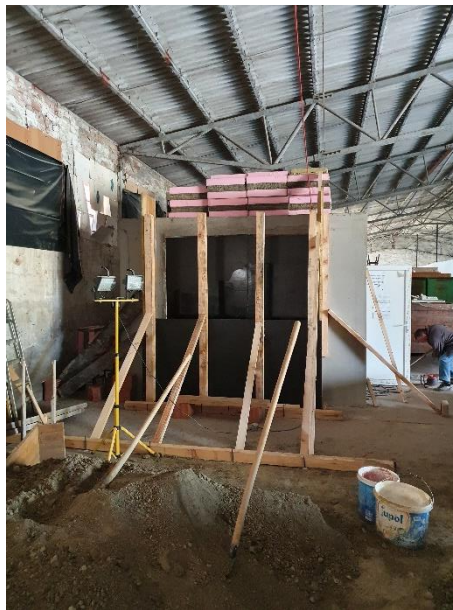
Slika 2.1 Postavljanje vanjskog dijela oplata zida
