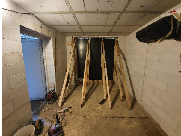
Slika 2.2 Oplata na unutarnjem dijelu zida
