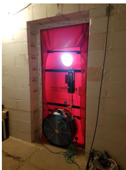
Slika 2.1 Oprema za ispitivanje zrakopropusnosti komore Blower door metodom
