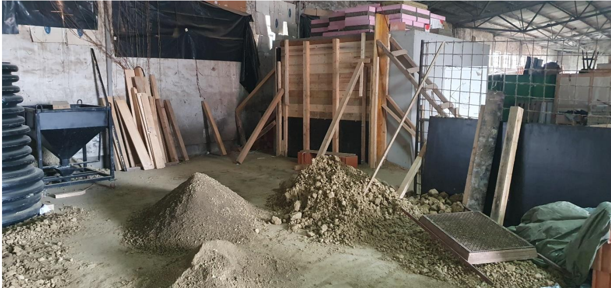
Slika 4.2 Priprema zemljanog materijala sisanjem
