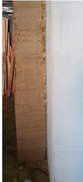
Slika 4.5 Zid W-RE bez slame između slojeva
