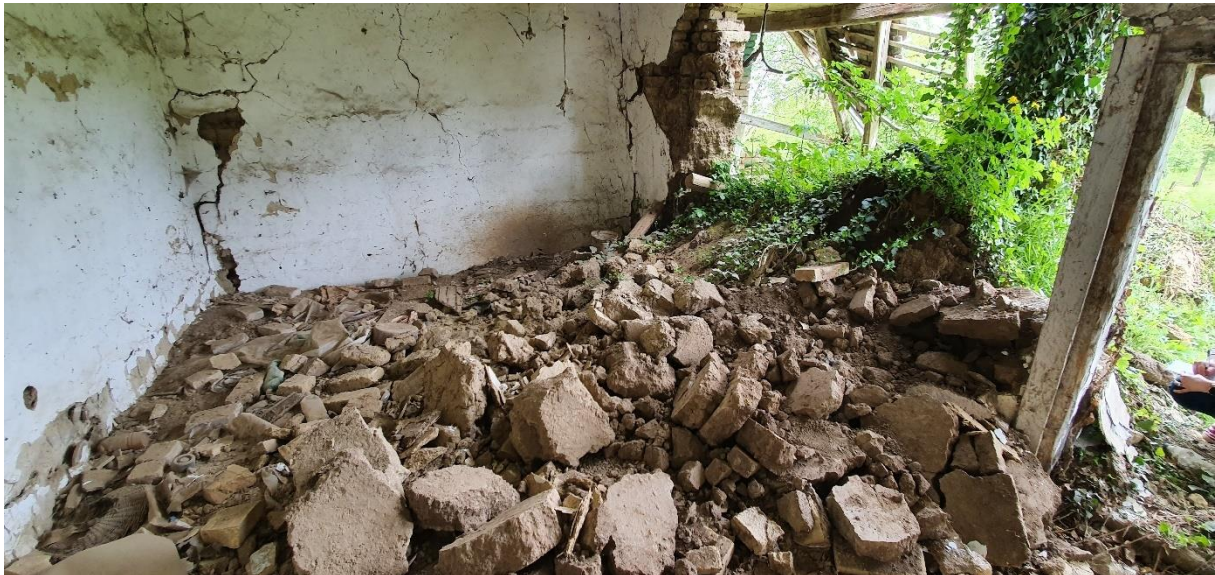
Slika 3.10 Zid nakon sloma uočen tijekom terenskog istraživanja (Aljmaš, Dunavska obala bb)
