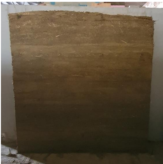
Slika 4.6 Završeni zid W-Re-f nakon uklanjanja oplate
