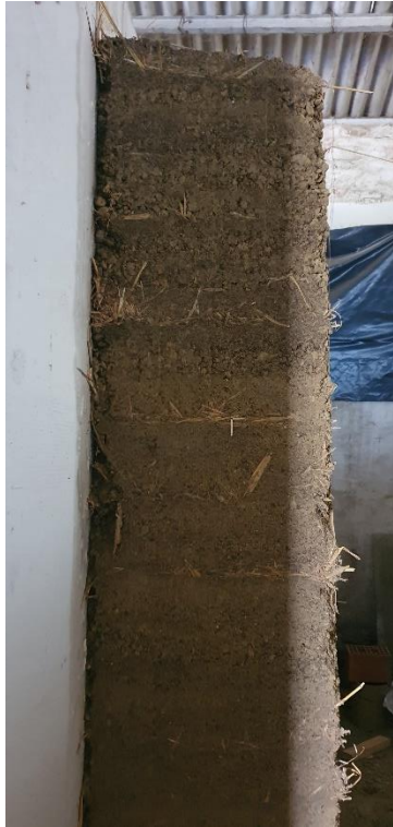
Slika 4.4 Zid W-Re-f sa slamom između slojeva
