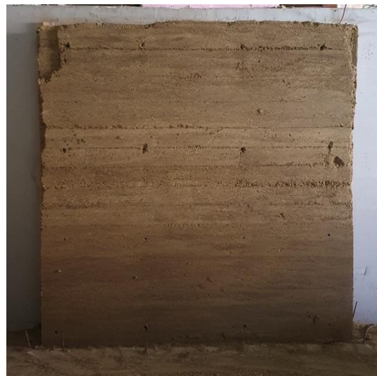
Slika 4.7 Završeni zid W-RE nakon uklanjanja oplate
