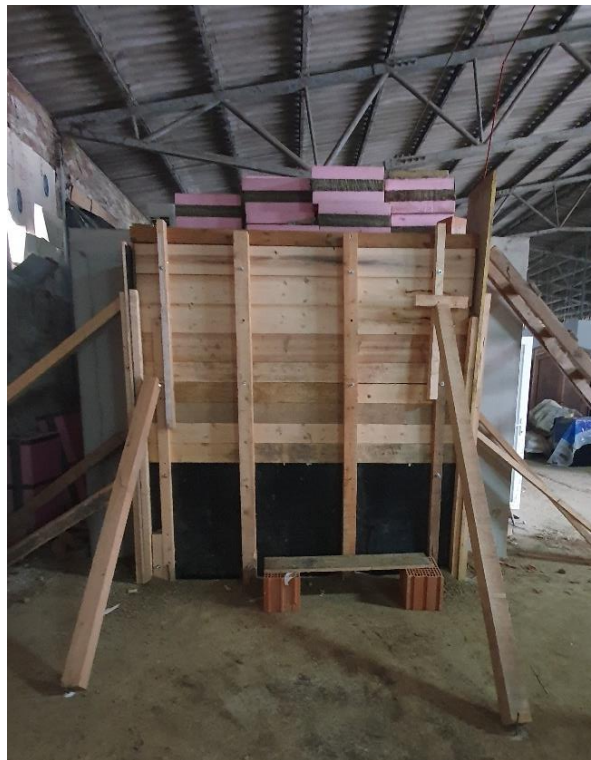
Slika 4.1 Postavljena oplata za izgradnju zida od nabijene zemlje osigurana kosnicima
