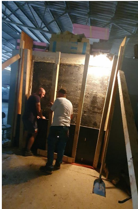
Slika 3.1 Postavljanje vanjskog dijela oplata zida
