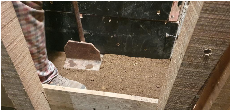
Slika 3.3 Gaženje i zbijanje materijala nabijačem
