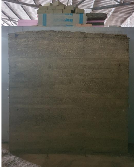
a) Zid od nabijene zemlje W3-OoP (zapadni zid)
