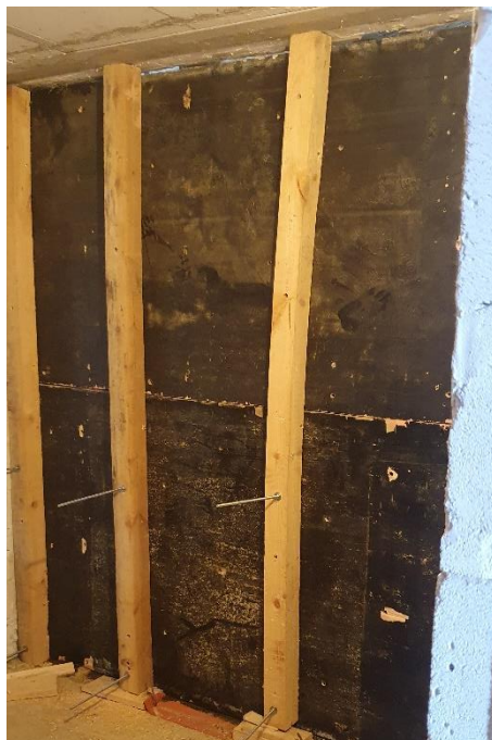
Slika 3.2 Oplata na unutarnjem dijelu zida
